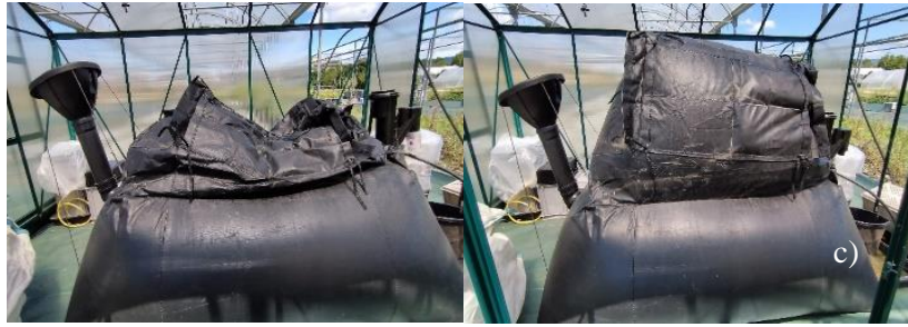
Figura 37. Evolución del pH y la temperatura (a), sólidos totales y sólidos volátiles del efluente (b) durante el proceso de digestión anaeróbica y aspecto del gasómetro con producción mínima y máxima de biogás (c)
