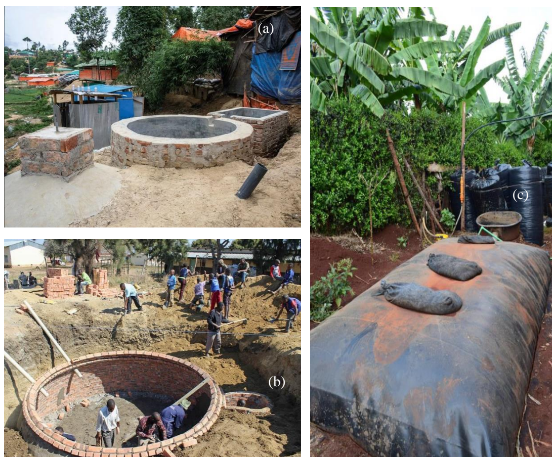
Figura 12. Biodigestor de cúpula fija (a) Campo de refugiados de Cox's Bazar en Bangladés (Kurkowska et al., 2019), (b) Campo de refugiados de Mpaka, Suazilandia (Presidian Editor, 2015), (c) Biodigestor tubular en Kenia región de Meru, Nyeri, Kericho (GIZ & EnDev, 2022)
