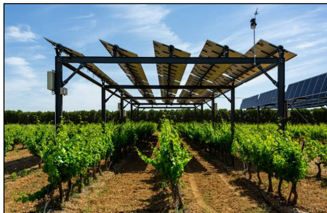
Ilustración 2: Instalación agrovoltaica en altura sobre un viñedo[9].
