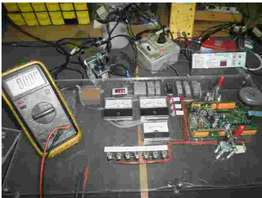
Figura 4. Puesto de verificación manual, que se pretende automatizar en el proyecto.
