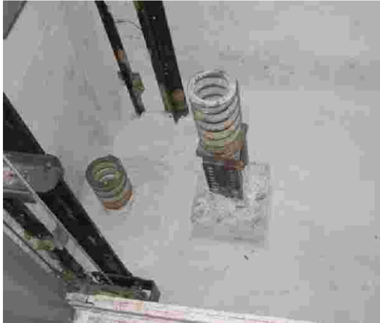
Figura 2. Amortiguadores de foso.
