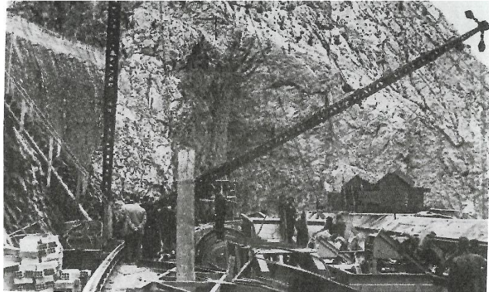
Blondines o “cables aéreos” instalados en Escales para el transporte de materiales por encima del congosto. Septiembre de 1951. R.Antas.
