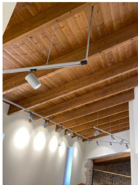
Detalle del techo. Planta primera.
