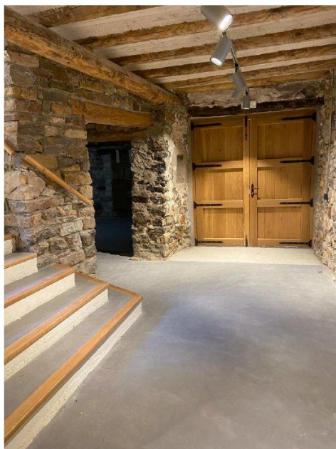
Vestíbulo de la planta semisótano.
