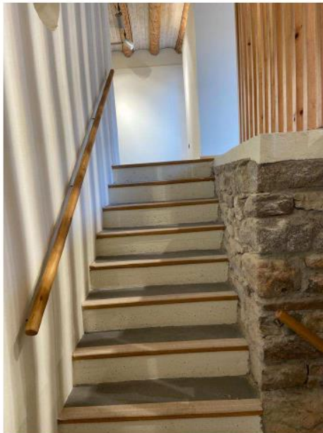
Escaleras de acceso a la planta baja.
