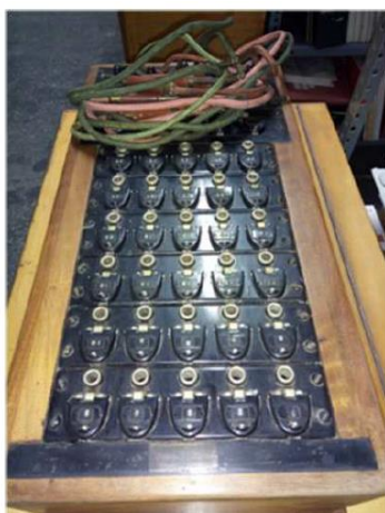
Centralita telefónica de ENHER que servía para comunicarse entre las distintas zonas de obras.
