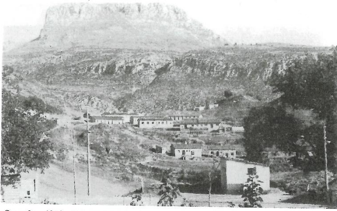
Campamento de trabajadores de ENHER en Sopeira. Incluía barracones dormitorio, comedor, servicios y centro sanitario. Septiembre de 1951. Anónimo.
