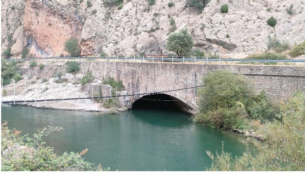
Canal de expulsión de agua tras generar electricidad. Fotografía propia.
