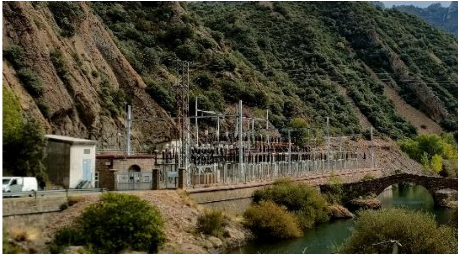
Pista de acceso a la Central y Estación Exterior. Fotografía propia.
