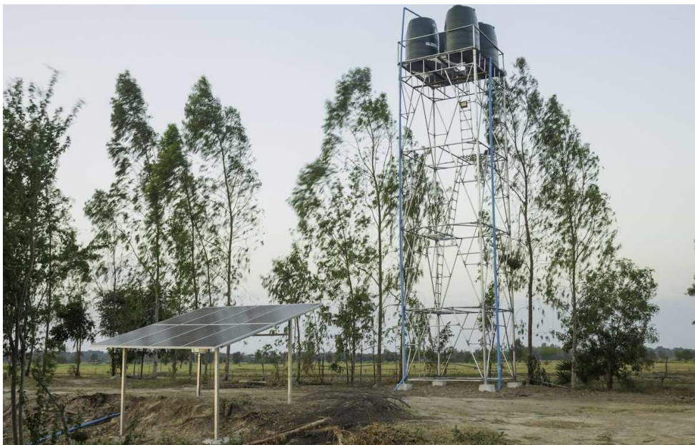
Figura 1-17. Estructura de almacenamiento de agua en altura para bombeo solar (SolarPlak, 2018)
