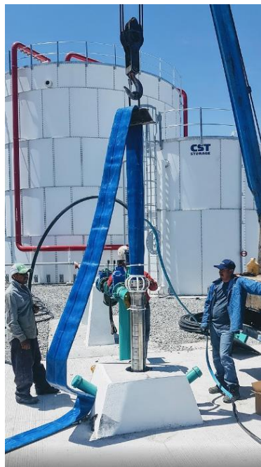
Figura 1-19. Instalación de bomba sumergible con tubería flexible, marca Coluflex (izquierda) e hidrociclón modelo F-700, marca Yamit (derecha).
