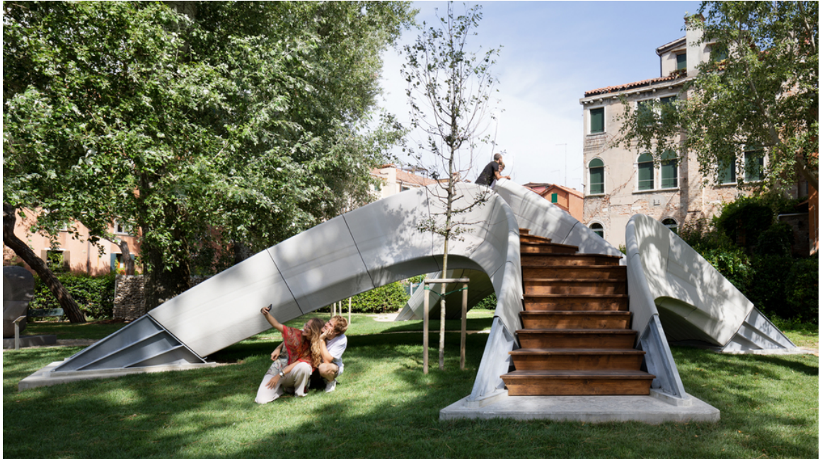
FIGURA 4.34: Puente Striatus , primer puente arqueado de hormigón impreso 3D.
