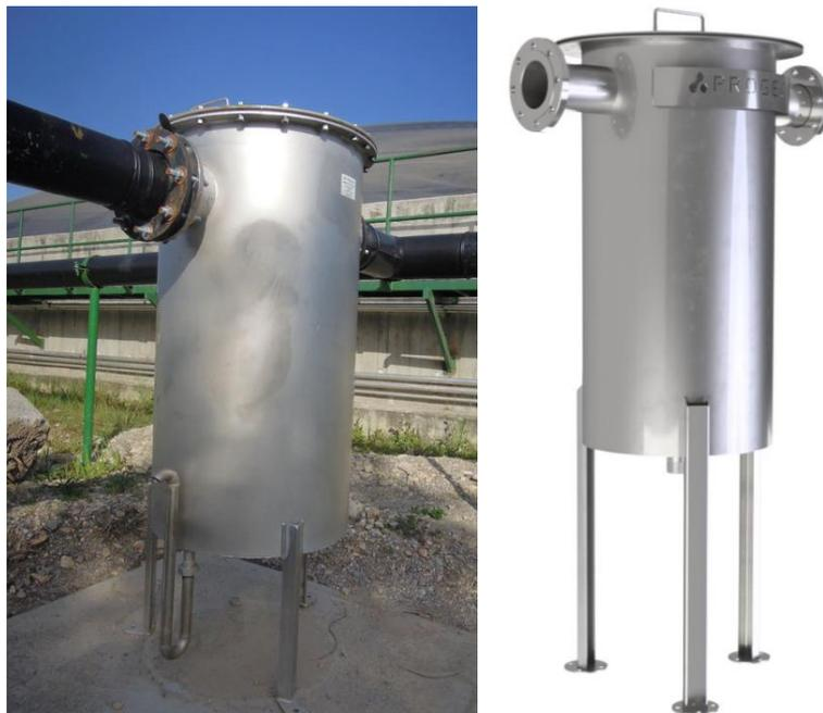
Ilustración 33. Trampa de Humedad para línea de biogás. Fuente <https://www.progecosrl.com/es/filtros-separadores-de-cicl%C3%B3n.html>
