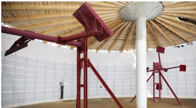
Ilustración 13. Agitador horizontal de paletas. Fuente: AGRIKOMP
