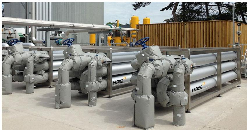
Ilustración 8. Sistema de calefacción externo al digestor. Fuente: HRS. Heat Exchangers
