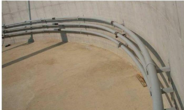
Ilustración 7 Tuberías de calefacción instaladas dentro del digestor. Fuente: Biogás Handbook
