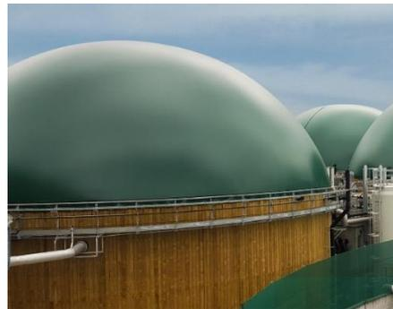
*Ilustración 4. Gasómetro de cúpula. Fuente: ZORG BIOGAS*
