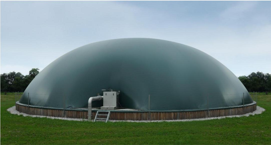
*Ilustración 6 Gasómetro seleccionado con una altura de  $1/3 D$ . Fuente: ZORG BIOGAS*
