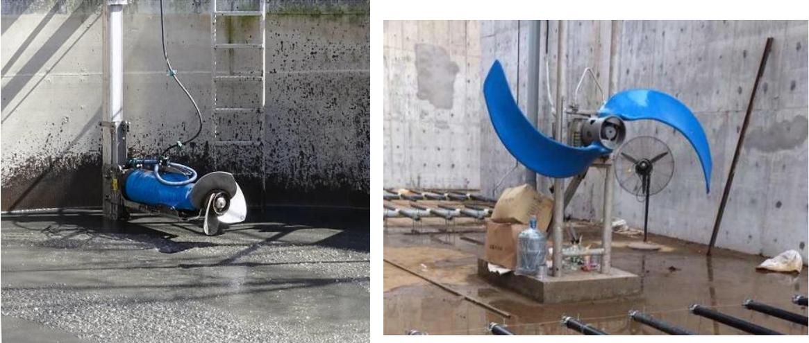
*Ilustración 10 Agitador de hélice sumergible de alta velocidad (Izquierda) y de baja velocidad (derecha)*
