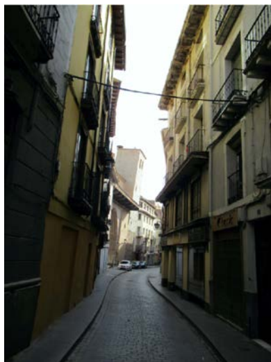
Ejemplo de basculamiento por consolidación afectando al torreón de la iglesia de San Pedro de los Francos
