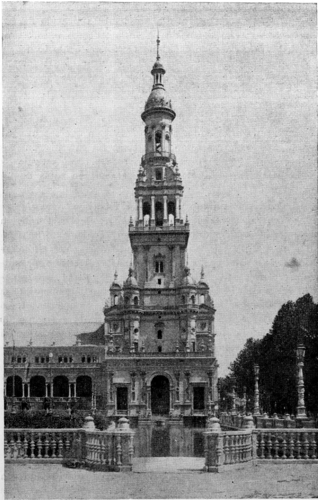
Edificio en que está instalada la Real Academia de Medicina de Sevilla
