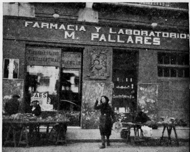
Fachada de la Farmacia y Laboratorio Pallarés, en Valencia, instalada en la popular plaza de Mosén Sorell
