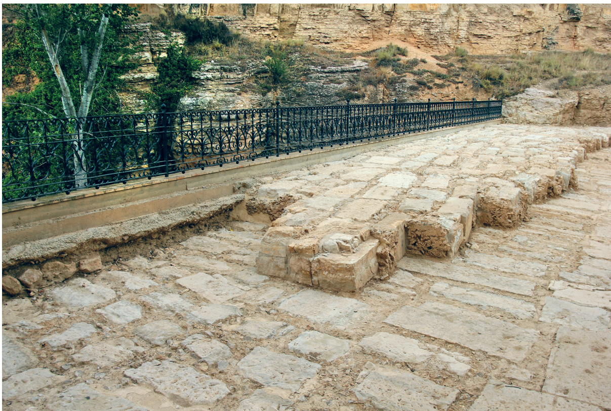
Figura 7. Coronamiento actual de la presa en el que se puede observar la variedad de los sillares empleados.
