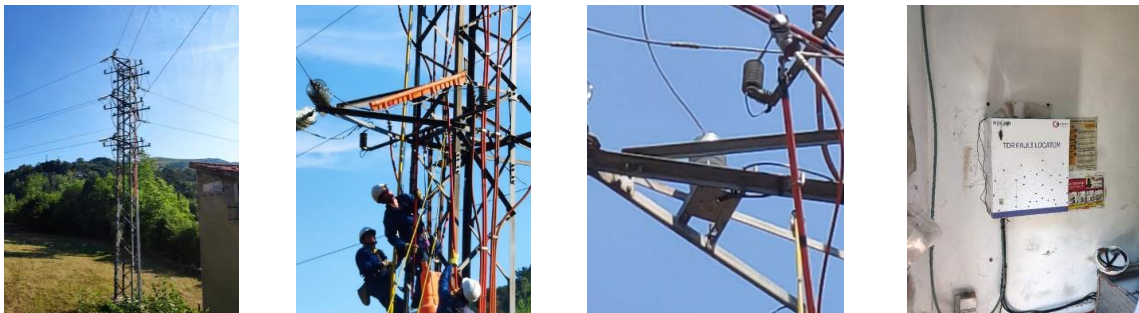
Figura 8. Imágenes de la instalación. De izquierda a derecha, poste al lado del C.T. donde instalar el localizador/Trabajos previos para instalación bajo tensión / Instalación de los acopladores / Armario del localizador instalado dentro del C.T.
