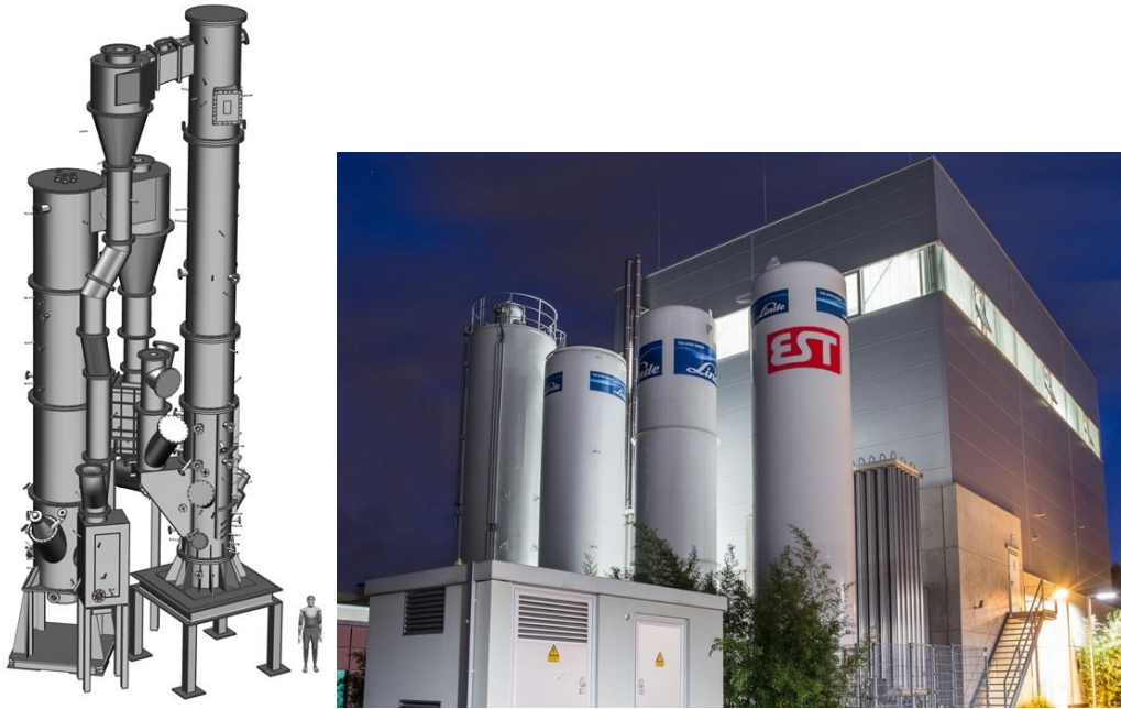
Figura 1.27. Esquema e imagen de la planta piloto de 1 MW t en TUD. Fuente: CLARA (2022).
