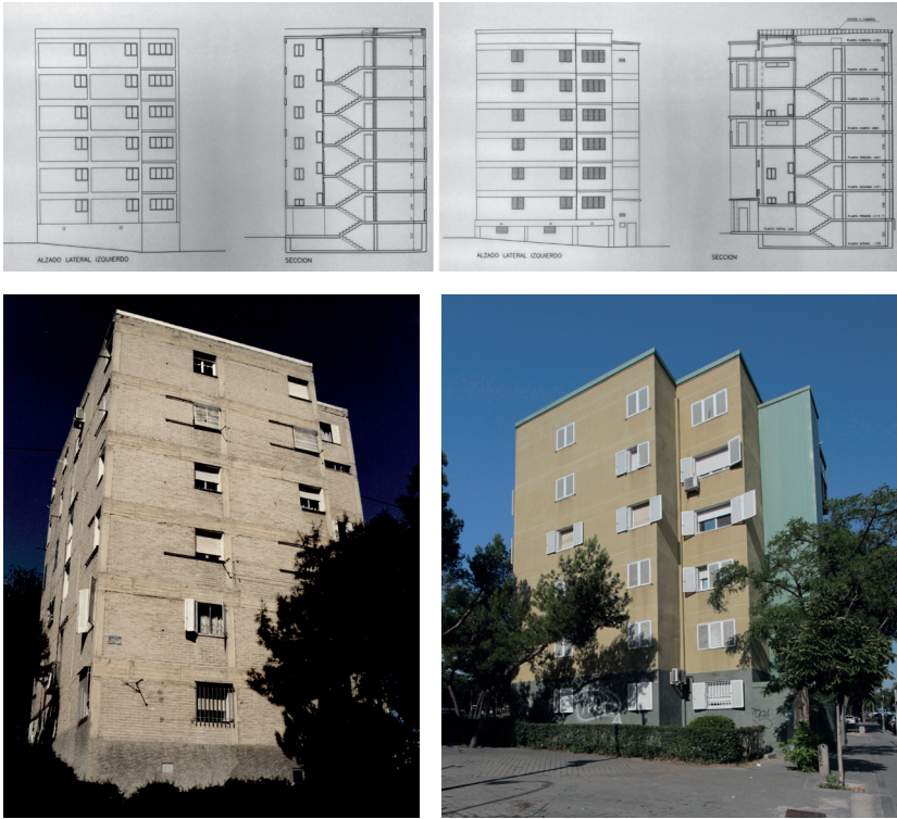
Fig. 4. Torre, estados inicial y rehabilitado (1994, 2020) / Tower, initial and rehabilitated state (1994, 2020) (© Archivo CREA Arquitectos y Noelia Cervero Sánchez)
