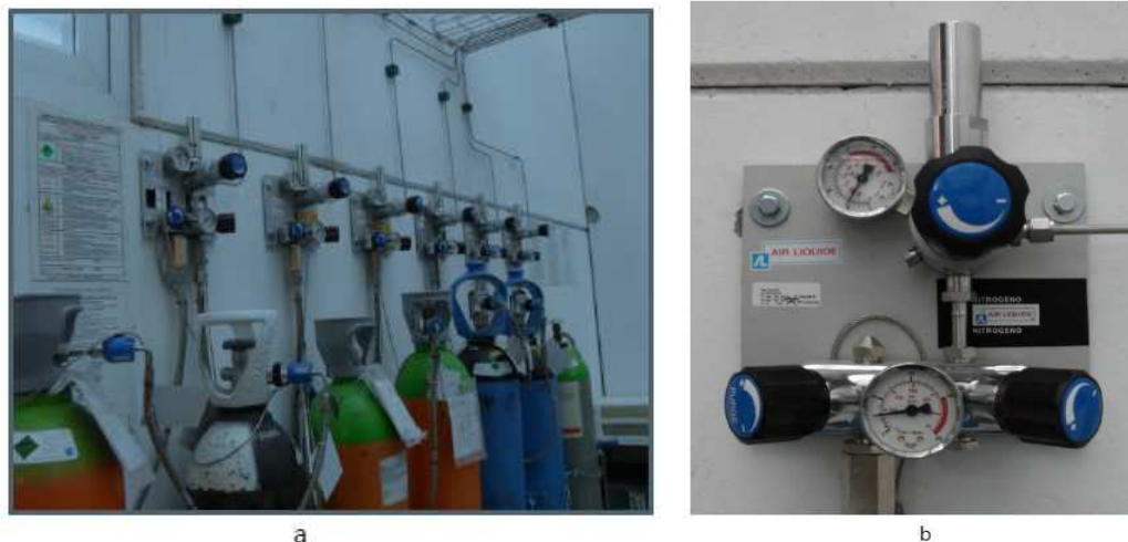
Figura B.2. (a) Botellas de gases conectadas a la instalación. (b) Elemento regulador de presión. El manómetro inferior indica la presión de la botella, el superior marca la presión en la línea.
