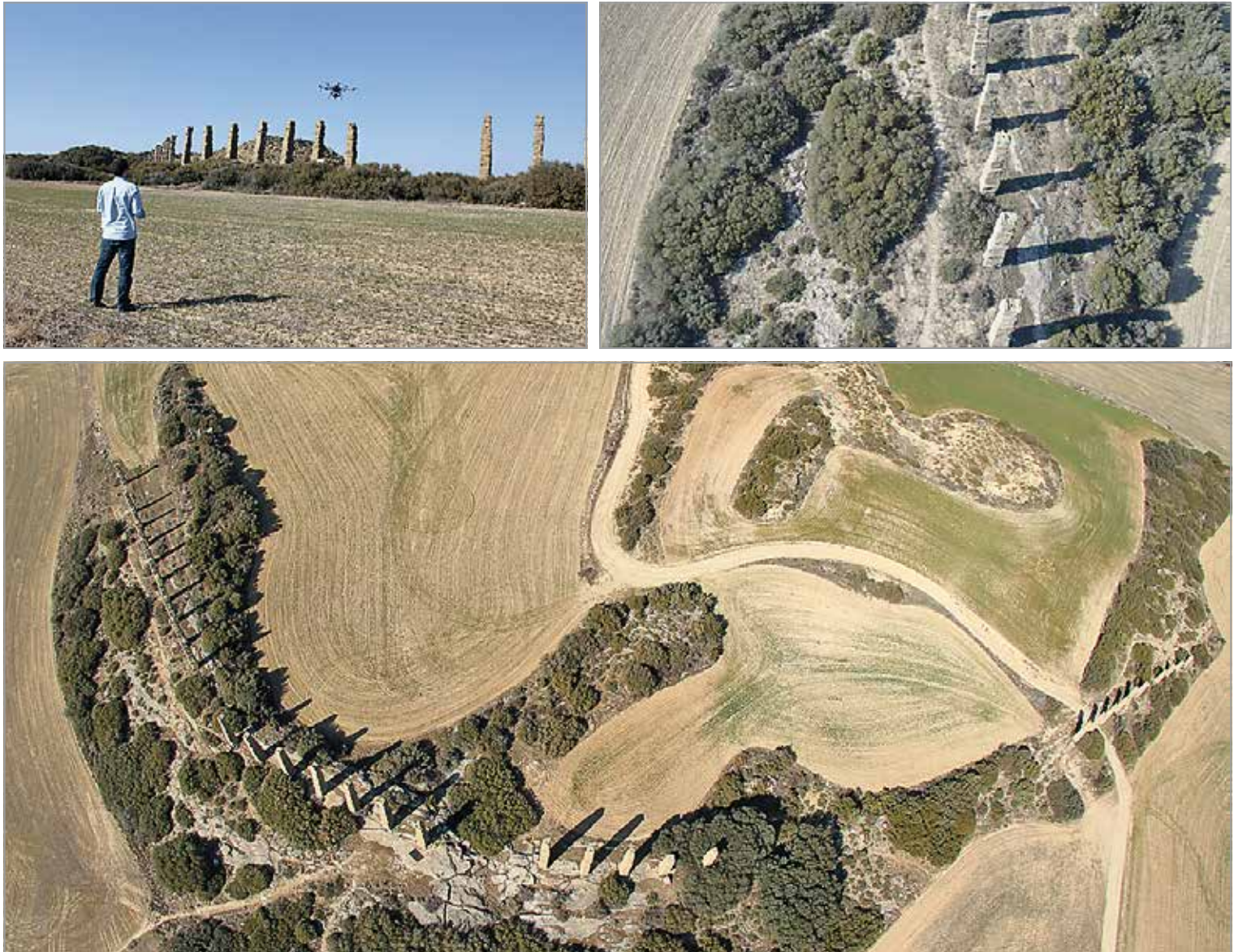
FIG. 181. Proceso de documentación aérea mediante fotogrametría aérea de baja altura con un dron.
