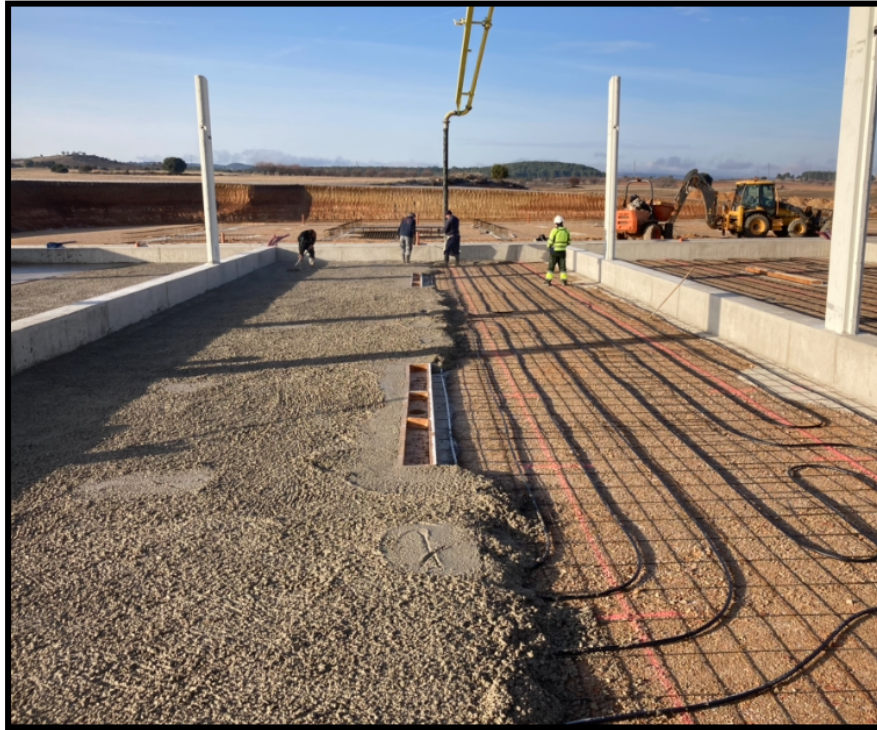
Fig. 2.8. Intercambiador geotérmico instalado en losa de hormigón ( Fuente propia ).
