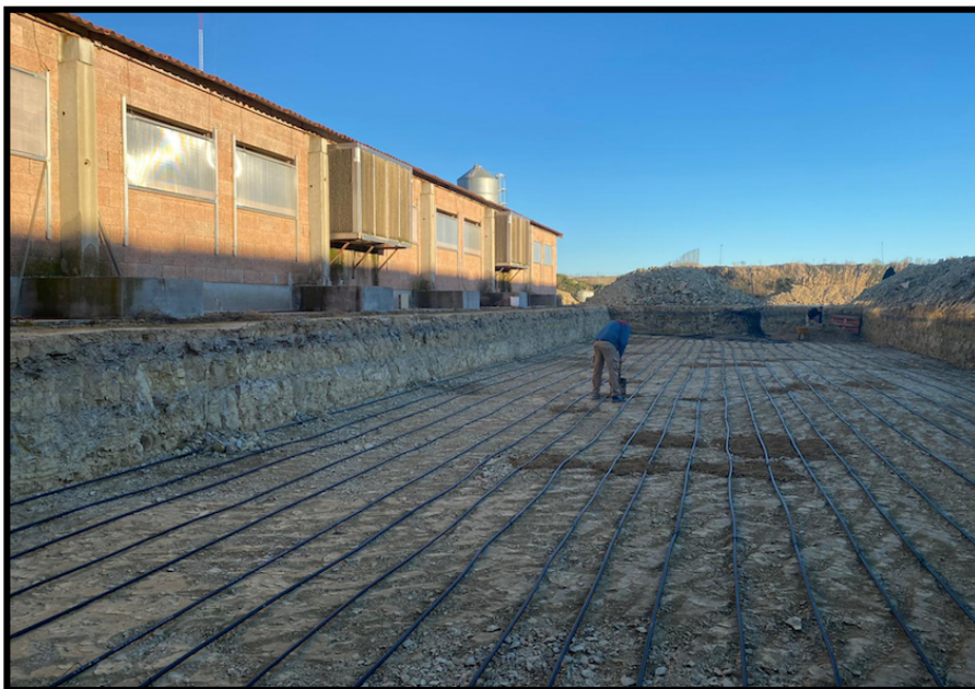
Fig. 2.7. Distribución de tubería de polietileno en un intercambiador geotérmico horizontal ( Fuente propia ).
