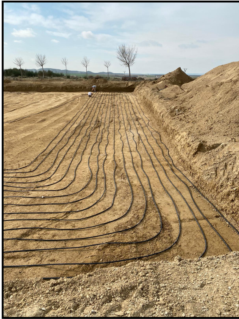
Fig. 3.13. Campo de captación horizontal en explotación ganadera ( Fuente propia ).
