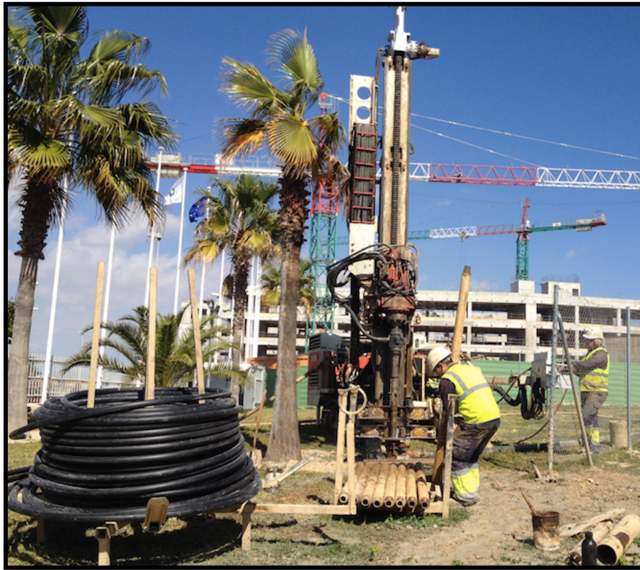
Fig. 2.6. Dos operarios introducen una sonda geotérmica en una perforación ( Fuente propia ).
