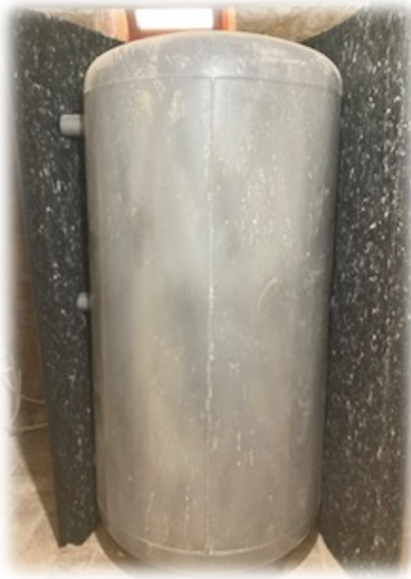
Fig. 3.23. Depósito de inercia ( Fuente propia )
