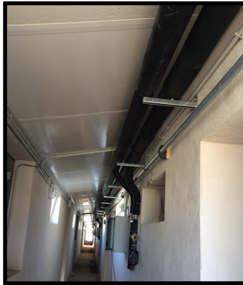
Fig. 3.26. Distribución hidráulica en interior de la nave ( circuito secundario ) ( Fuente propia ).
