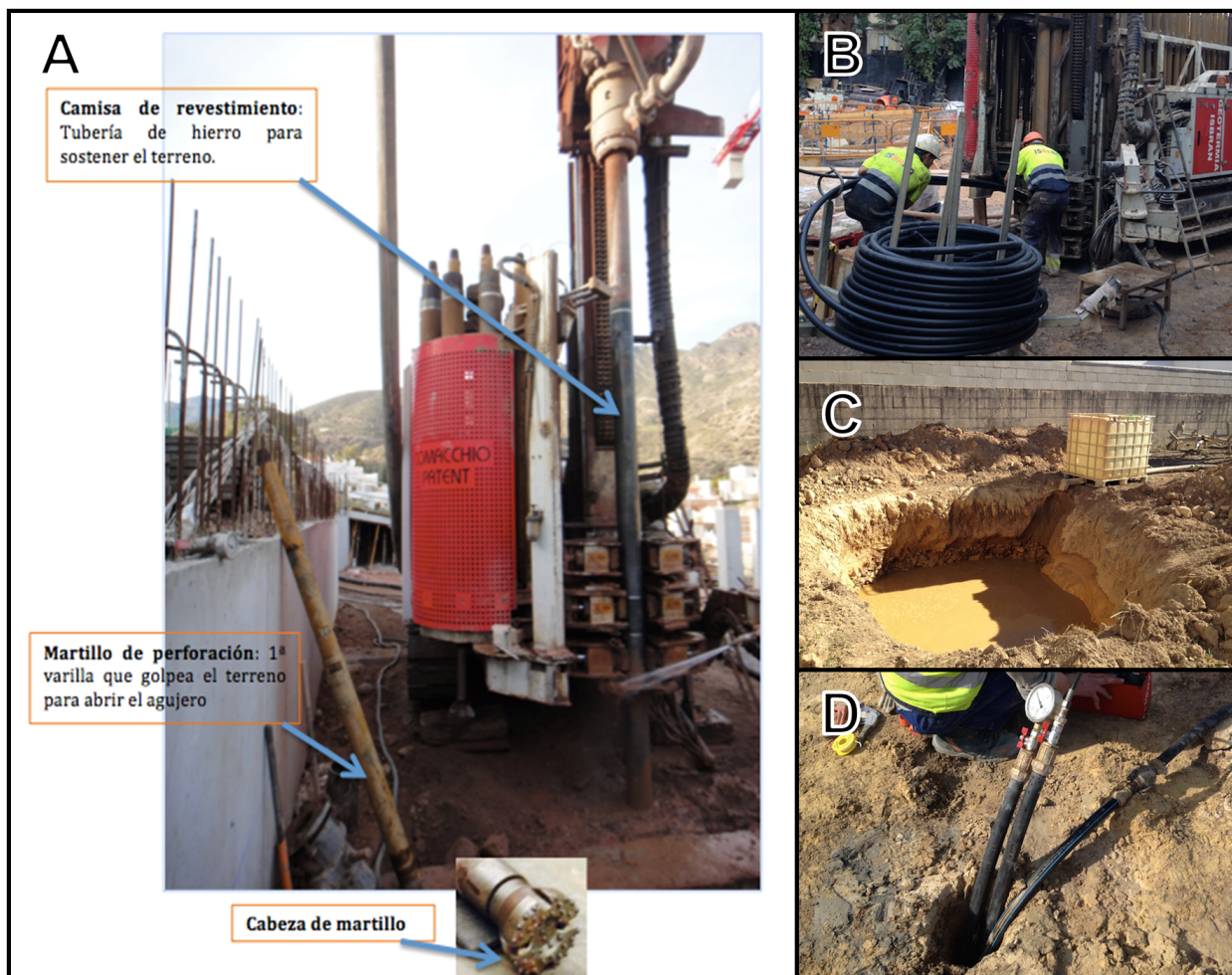
Fig.3.11. (A) Máquina perforadora y accesorios de la misma. (B) Introducción de una sonda geotérmica en la perforación. (C) Balsa de detritus. (D) Prueba de presión en intercambiador geotérmico en “U” (sonda geotérmica) y tubo de inyección lechada termoactiva (Fuente propia).
