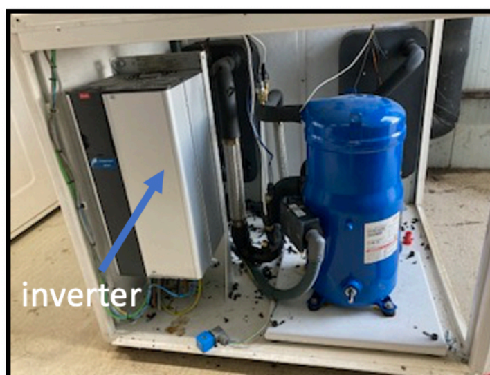
Fig. 3.20. Interior de una BCG Ecoforest (Fuente propia)
