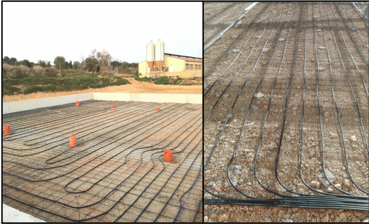
Fig. 3.14. Ejemplos de termoactivación de los cimientos tipo losa de naves de granjas porcinas (puritermia) (Fuente propia).
