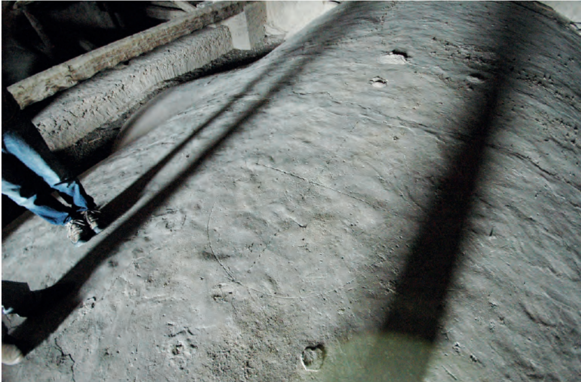
Fig. 32. Alcañiz (Teruel). Colegial de Santa María la Mayor. Monte en el trasdós de las bóvedas. Foto: Javier Ibáñez Fernández.
