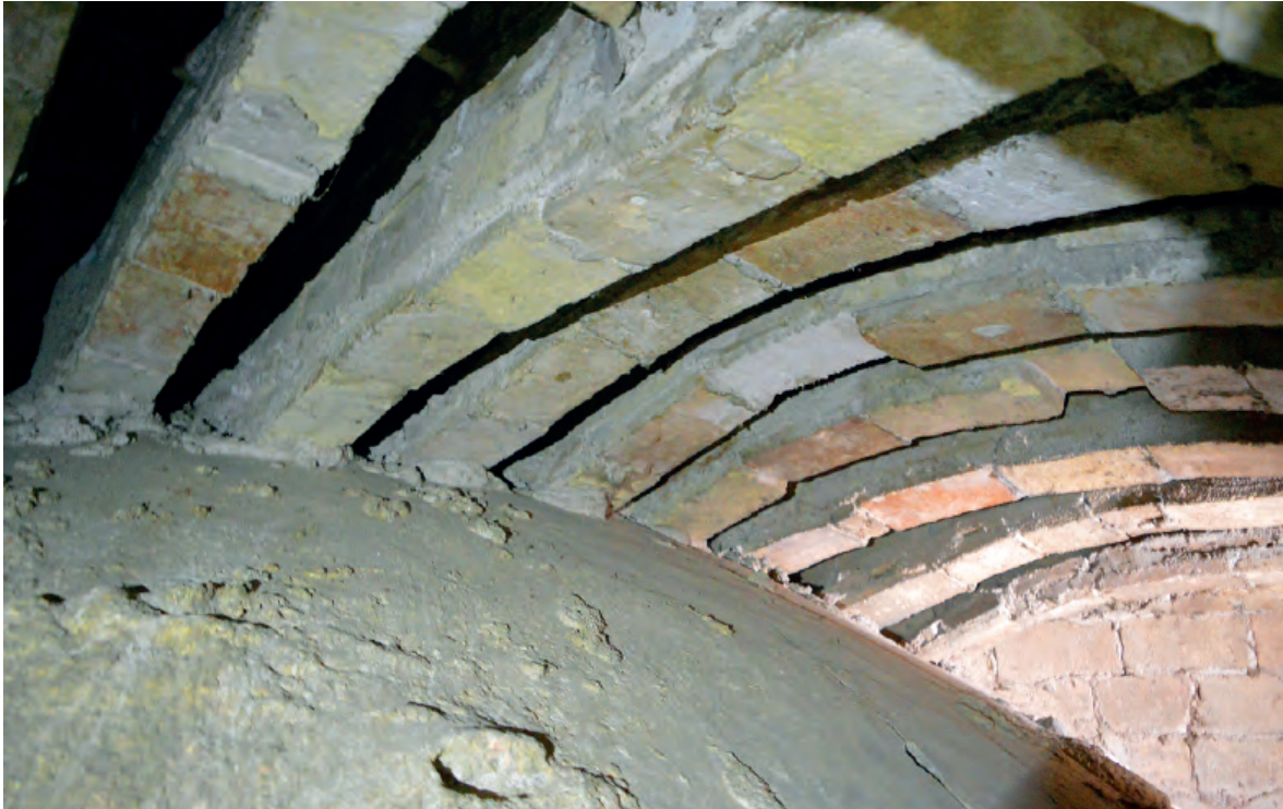
Fig. 46. Lécera (Zaragoza). Iglesia de Santa María Magdalena. Detalle de los tabiquillos del bajocubierta de la zona de la cúpula. Foto: Jorge Martín Marco.
