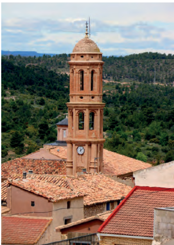
Fig. 127a. Crivillén (Teruel). Iglesia de San Martín. Exterior. Torre campanario. Foto: SIPCA.
