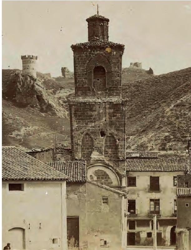
Fig. 90b. Daroca (Zaragoza). San Andrés. Exterior. Foto cortesía del Centro de Estudios del Jiloca.
