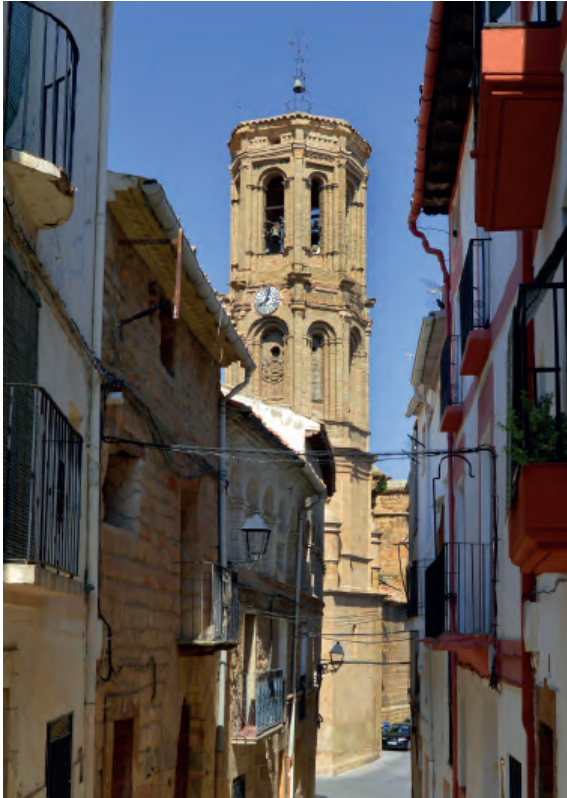
Fig. 115. Andorra (Teruel). Iglesia de la Natividad. Exterior. Torre campanario. Foto: Jorge Martín Marco.
