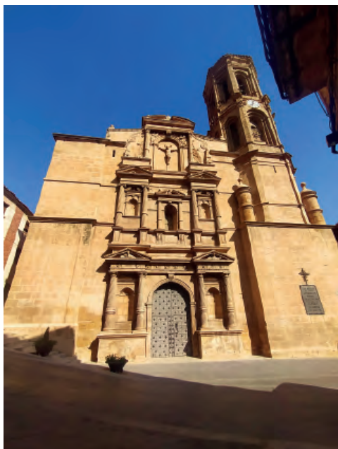
Fig. 101a. Andorra (Teruel). Iglesia de la Natividad. Exterior. Foto: Jorge Martín Marco.
