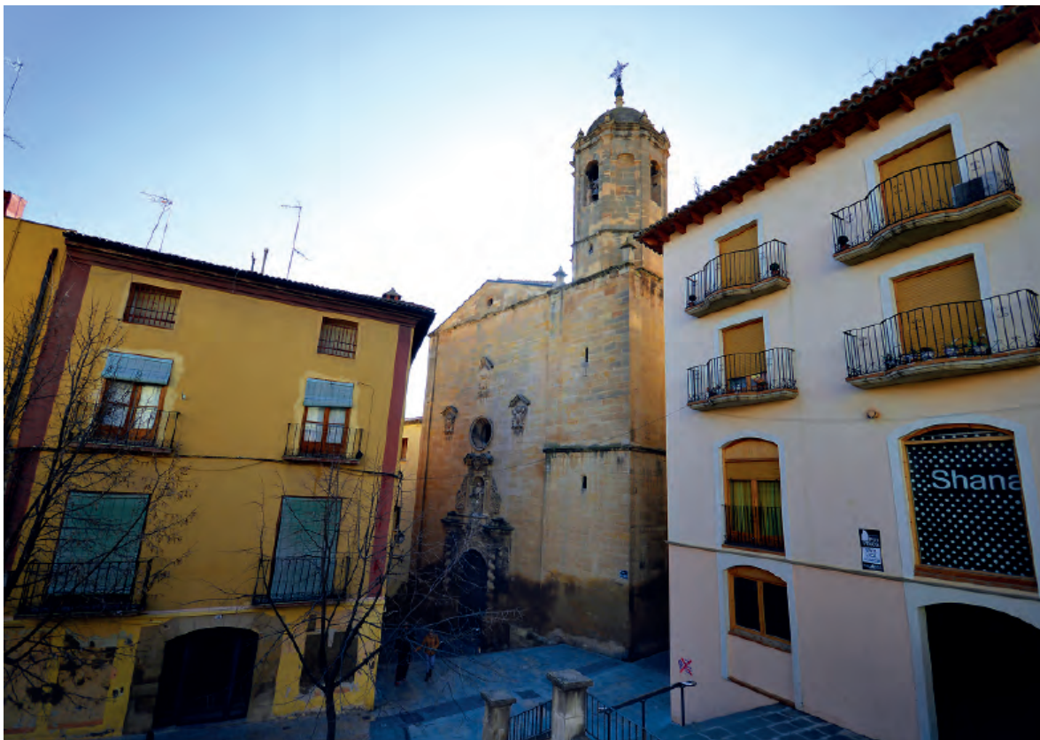
Fig. 120b. Alcañiz (Teruel). Convento del Carmen. Iglesia. Exterior. Torre campanario. Foto: Jorge Martín Marco.
