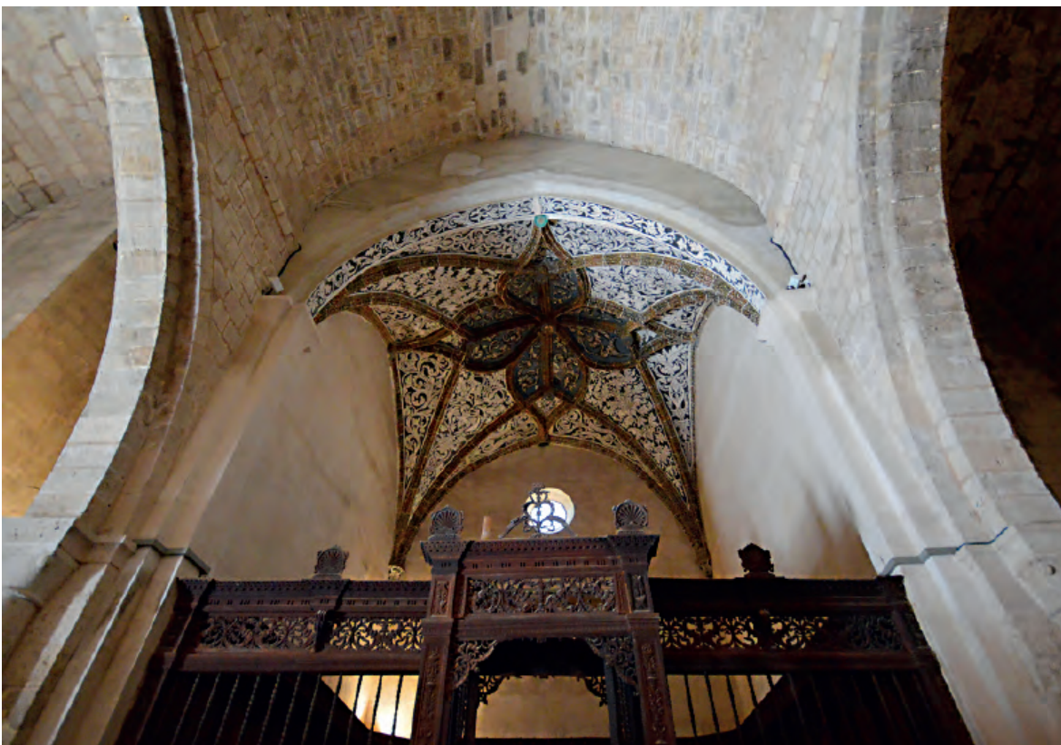
Fig. 90c. Daroca (Zaragoza). San Miguel. Interior. Tramo del coro. Foto: Jorge Martín Marco.
