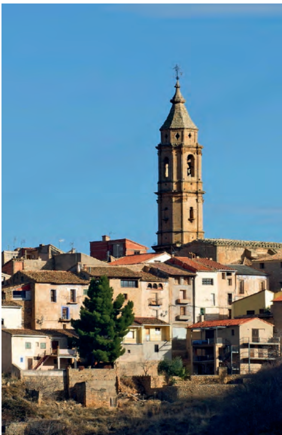
Fig. 125c Torre del Compte (Teruel). Iglesia de San Pedro. Exterior. Torre campanario. Foto: Jorge Martín Marco.
