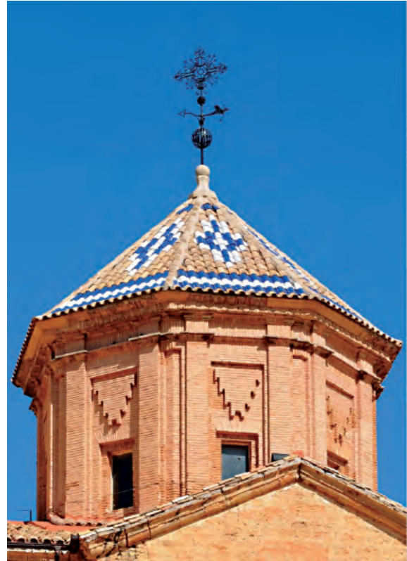
Fig. 53b. Belmonte de San José (Teruel). Iglesia del Salvador. Exterior. Foto: Francisco Climent.
