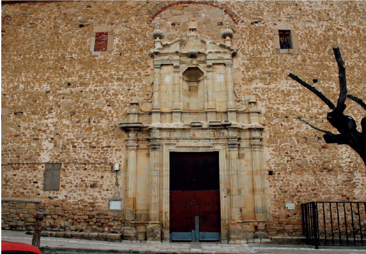
Fig. 104. Puertomingalvo (Teruel). Iglesia de la Asunción. Exterior. Foto: Pablo Cercós Maicas.
