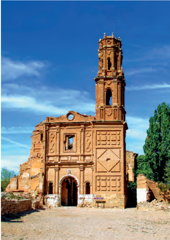
Fig. 126a. Belchite (Zaragoza). Convento de San Agustín. Iglesia. Exterior. Torre campanario. Foto: MaGrc.
