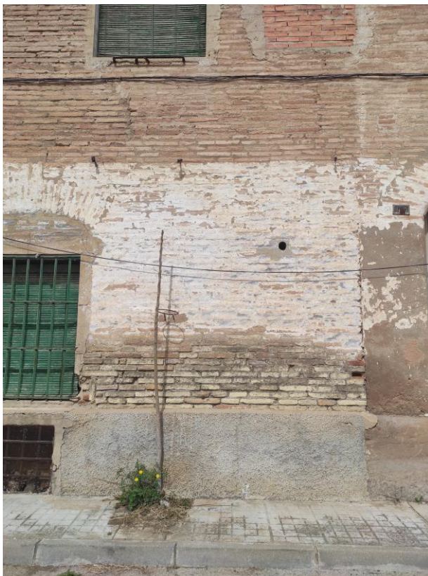
Detalle del revestimiento de cal y del blanqueado
