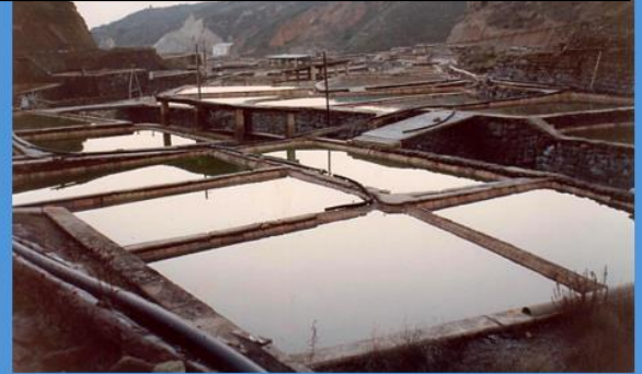
Fotografía de las salinas de Peralta en la etapa más moderna de su explotación. Se observa la sustitución de los canales de madera por tubos.
