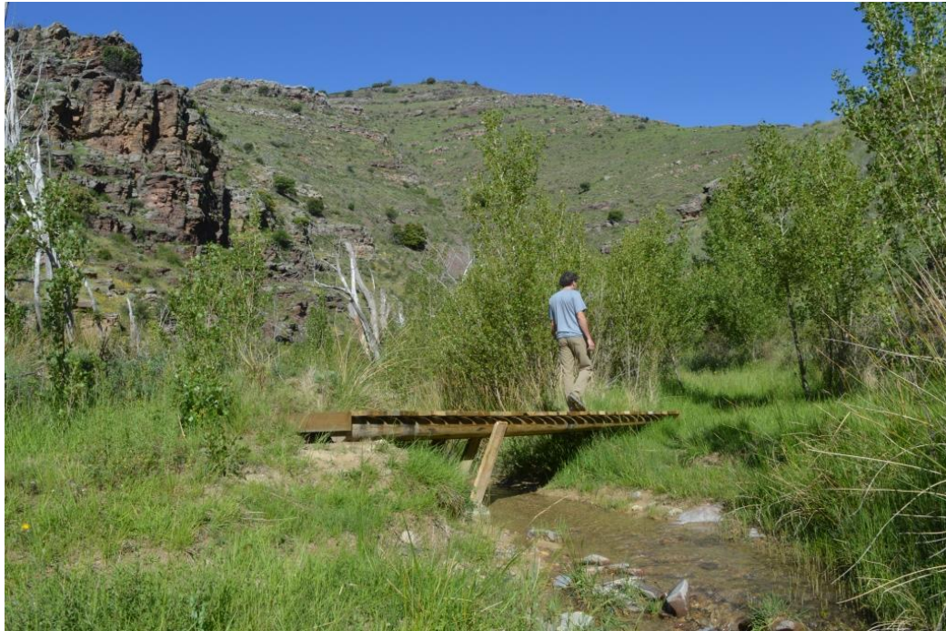
Figura 3. Fotografía de Barranco de Valdeplata en el que se observa una de las paralelas que hay para facilitar el acceso a las minas. Obtenida de Wikiloc
