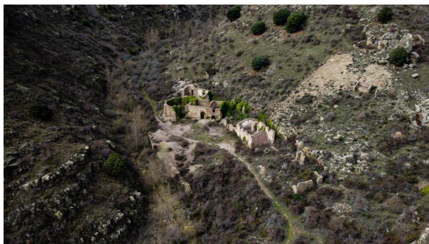
Figura 18. Panorámica con vista aérea actual de los edificios que quedan en pie (izquierda) y escombreras (derecha).
