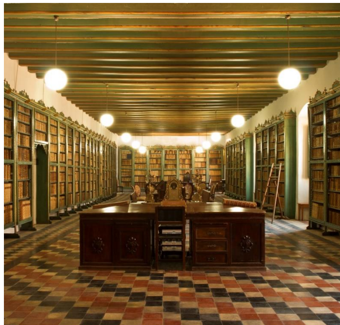
Figura 22. Sala principal de la biblioteca antes del desmontaje de los libros y reparación de las librerías. Fuente: Fotografía cortesía de la Delegación de Patrimonio Cultural de la Diócesis de Zaragoza.
