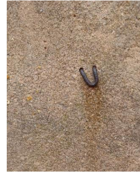
Ilustración 25. Detalle de una argolla en el muro interno del nido de ametralladora, "Pancho Villa", La Puebla de Valverde [Foto: Ester Morón, 2024].
