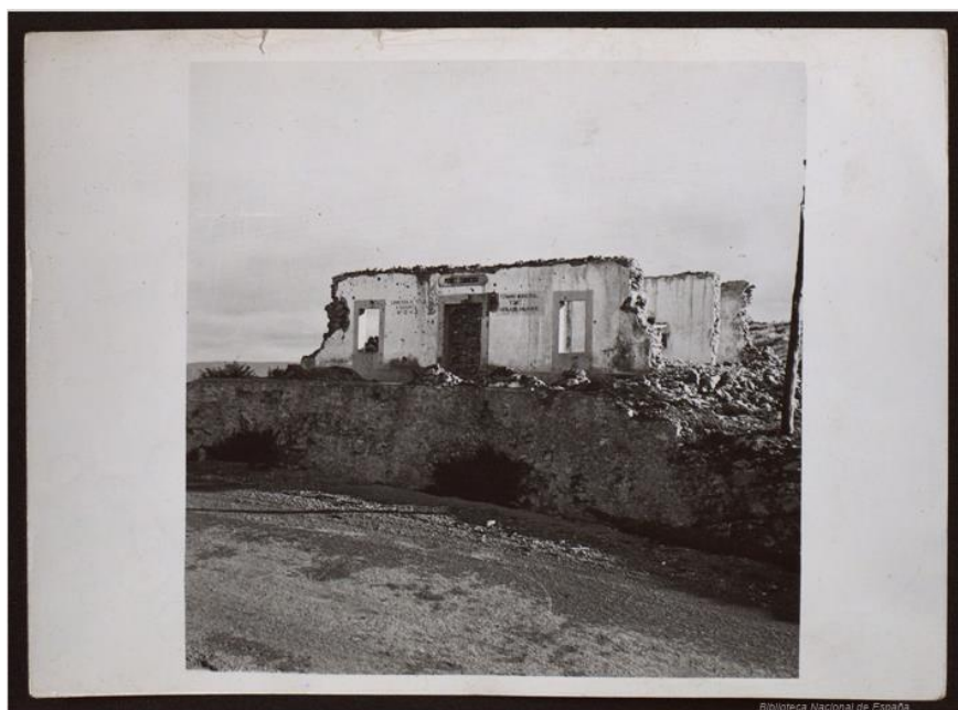
Ilustración 13. Caseta de peones del Alto del Puerto de Escandón, La Puebla de Valverde [Biblioteca Nacional de España].
