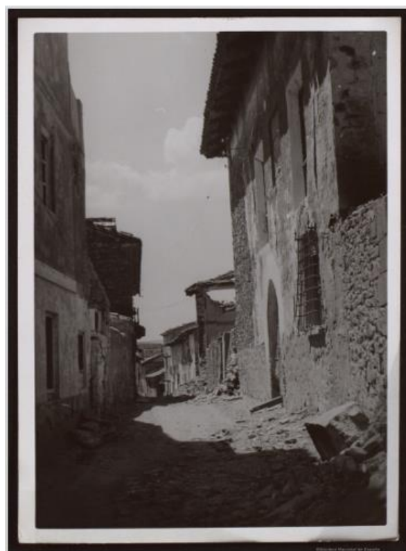
Ilustración 27. Una calle con casas destruidas, La Puebla de Valverde, 01-06-1938 [Biblioteca Nacional de España].
