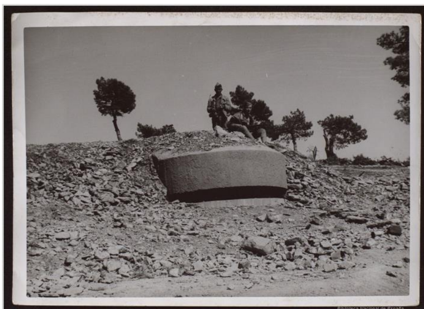
Ilustración 21. Entrada en la fortificación llamada Mirador de Prieto en Cerro Gordo desde donde D. Inda presenció las operaciones de Teruel, La Puebla de Valverde, 29-05-1938 [Biblioteca Nacional de España].
