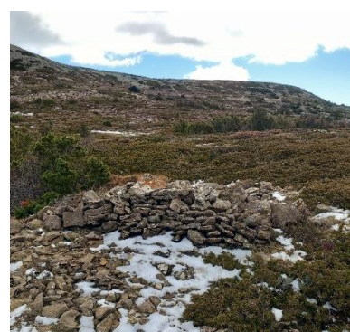
Ilustración 58. Parapeto de piedra, Alto del Buitre, La Puebla de Valverde [Foto: Ester Morón, 2024].
