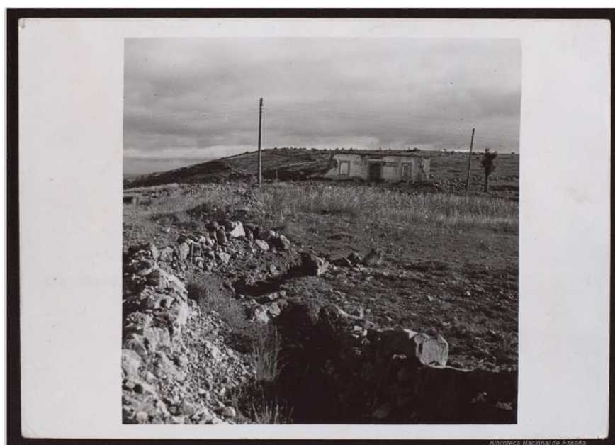
Ilustración 12. Fortificaciones en el Puerto de Escandón construidas por el bando republicano, La Puebla de Valverde [Biblioteca Nacional de España].
