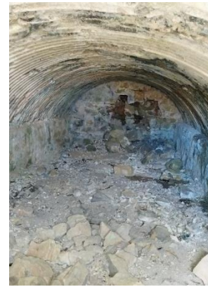
Ilustración 63. Interior del refugio, Alto del Buitre, La Puebla de Valverde [Foto: Ester Morón, 2024].
