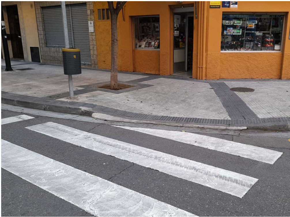
Imagen 3. Paso rebajado, sin baldosa distintiva (CRND). Fuente: elaboración propia
