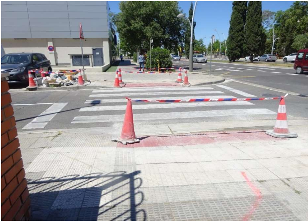
Imagen 7. Sustitución del pavimento por baldosa podotáctil.
