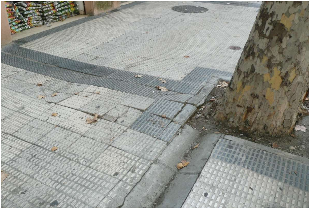
Imagen 5. Baldosas levantadas por empuje de raíces en calle Sobrarbe. Fuente: elaboración propia
