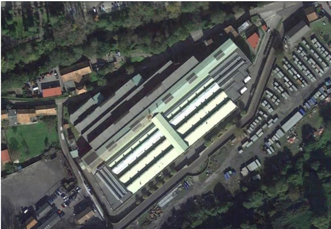
Ilustración 3: Ejemplo de Instalación fabril en Asturias sometida a un PMS. Fuente: Google Maps
