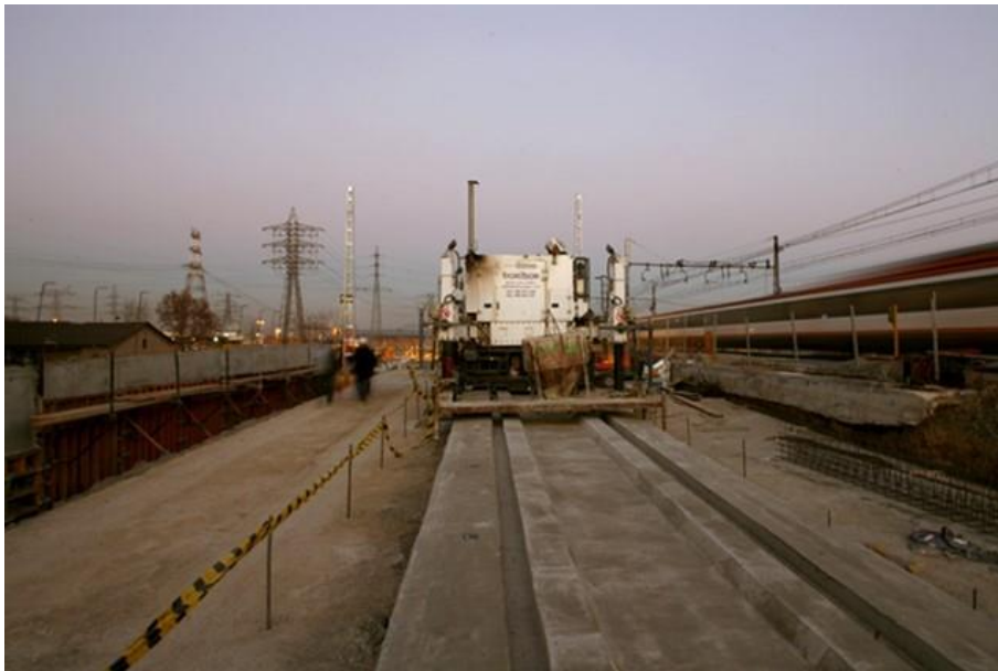
Ilustración 43: Ejecución de placa de hormigón con extendidora dejando acanaladuras para alojar el carril. L.A.V. Madrid-Zaragoza-Barcelona. El Prat de Ll. Año 2007. Fuente propia.
