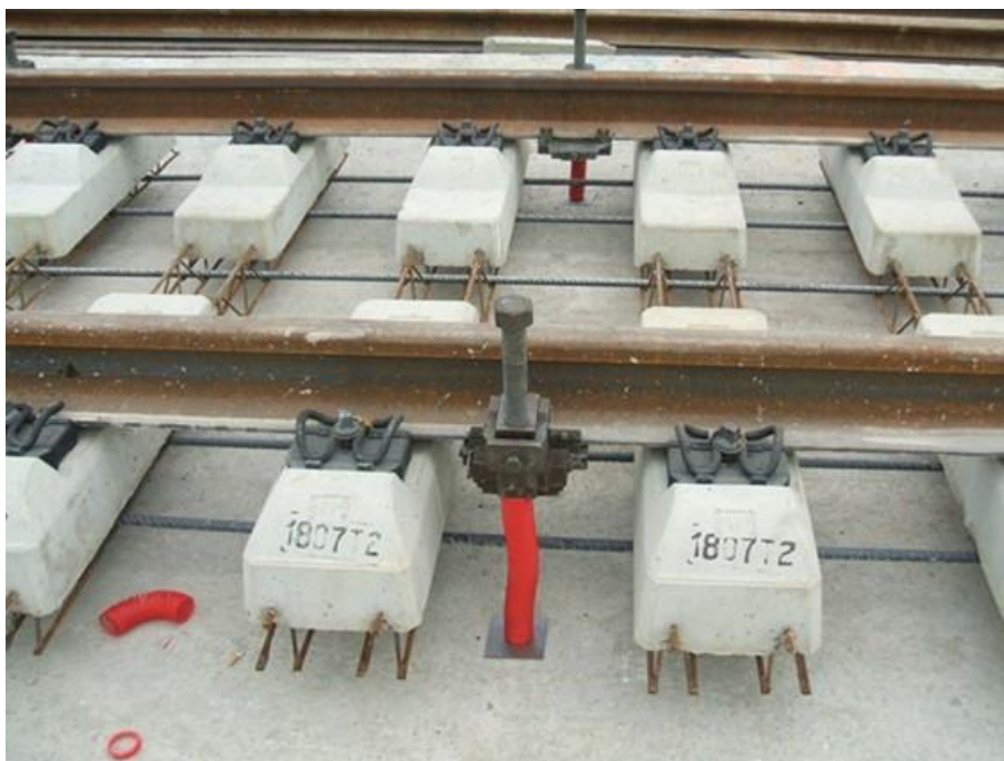
Ilustración 41: Vía en placa con traviesa Rheda 2000 [33] antes de hormigonar. L.A.V. Madrid-Zaragoza-Barcelona. El Prat de Ll. Año 2007. Fuente propia.
