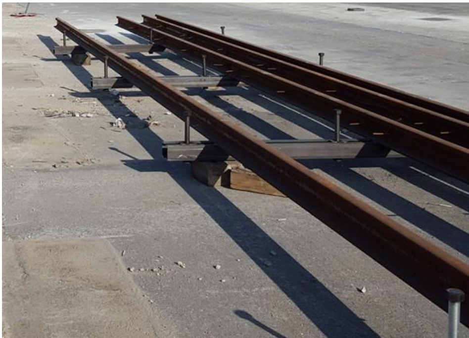
Ilustración 45: Vía en placa de 3 anchos premontada sobre perfiles en el puerto de Barcelona. Año 2015. Fuente propia.
