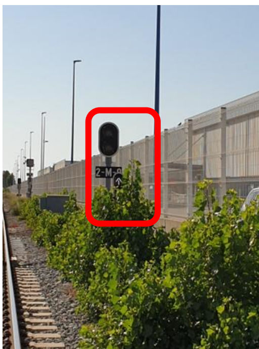
Ilustración 2: Señal ferroviaria ocultada parcialmente por la vegetación. Fuente propia.
