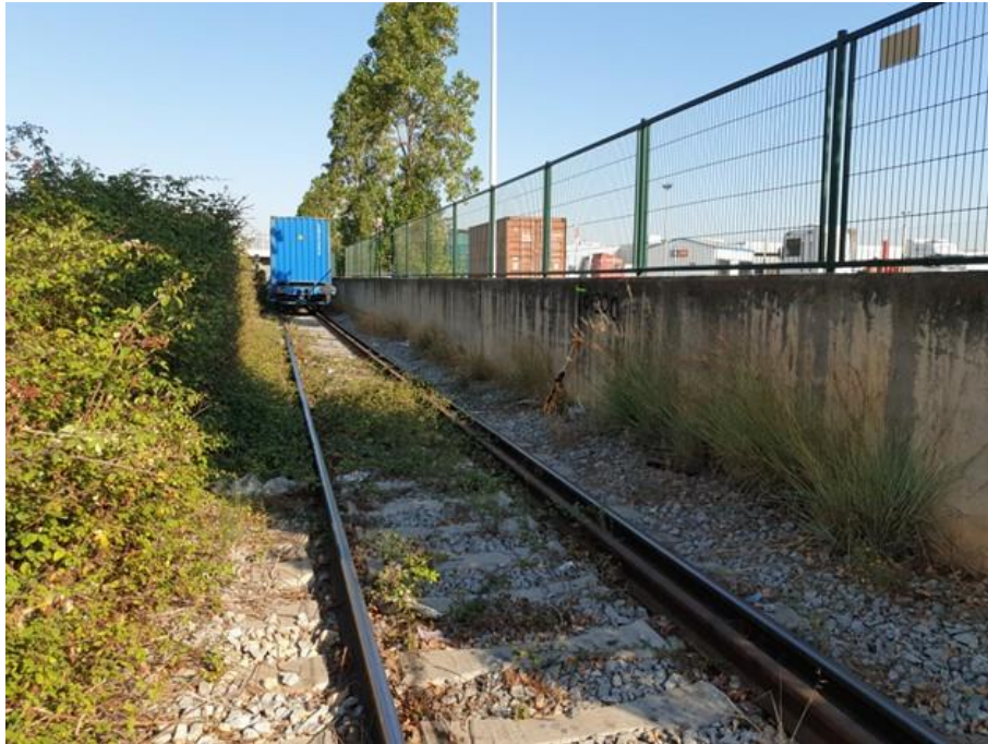
Ilustración 3: Vegetación en gálibo ferroviario. Fuente propia.
