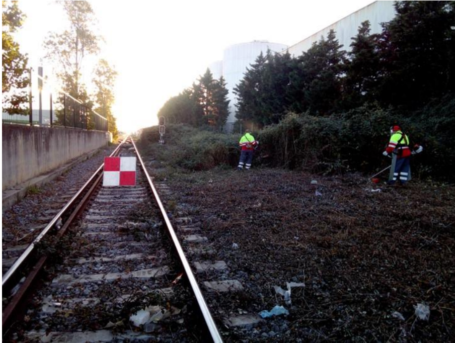
Ilustración 4: Desbroce de zarzas secas en plataforma ferroviaria. Fuente propia.
