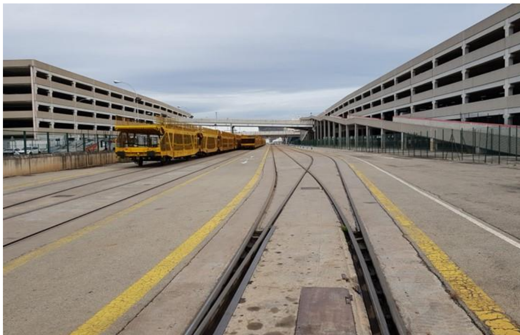
Ilustración 35: Terminal carga/descarga de vehículos. Vía con carril embebido de ancho ibérico. Puerto de Barcelona. Fuente propia.
