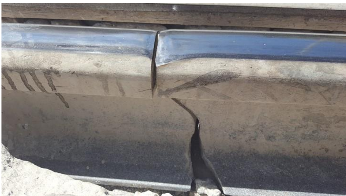
Ilustración 52: Carril partido una vez repicado el hormigón de la vía en placa. Fuente propia.
