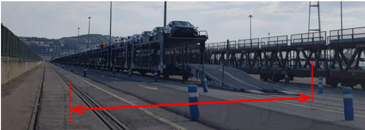
Ilustración 67: Entreeje en una terminal de carga/descarga de vehículos en el puerto de Barcelona. Fuente propia.
