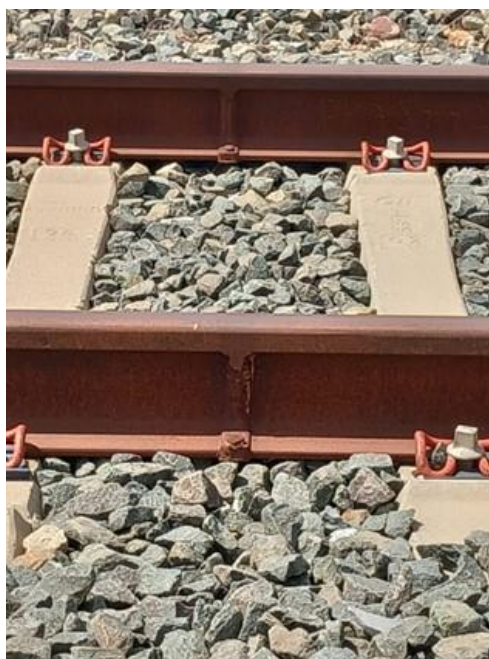
Ilustración 59: Soldaduras aluminotérmicas. Fuente propia.
