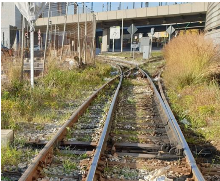
Ilustración 70: Desvío mixto con una rama en ancho métrico y la otra en ancho ibérico en carril RN45 en el Puerto de Barcelona. Fuente propia.
