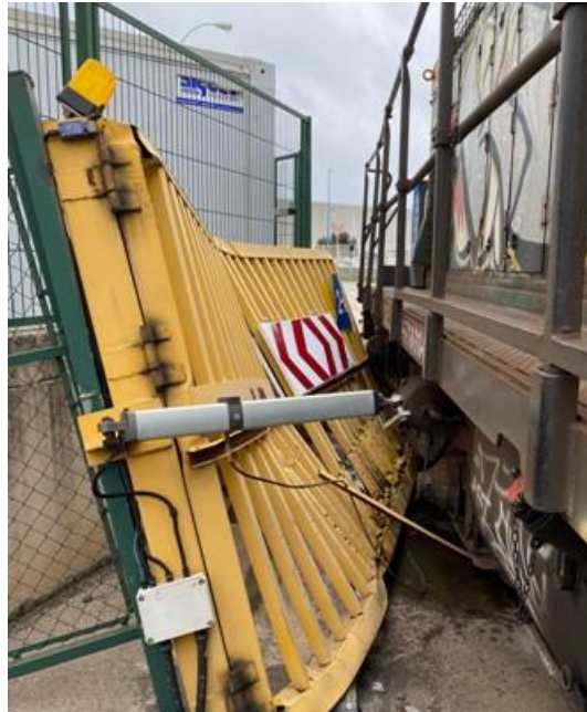
Ilustración 81: Puerta ferroviaria enganchada al paso del tren a causa del viento. Fuente propia.
