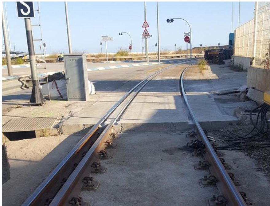
Ilustración 33: Abajo sistema de falsas traviesas tipo e-Clip SRS de Pandrol [36] con carril al aire, y arriba carril embebido con perfiles metálicos a modo de traviesas. Puerto de Barcelona. Fuente propia.
