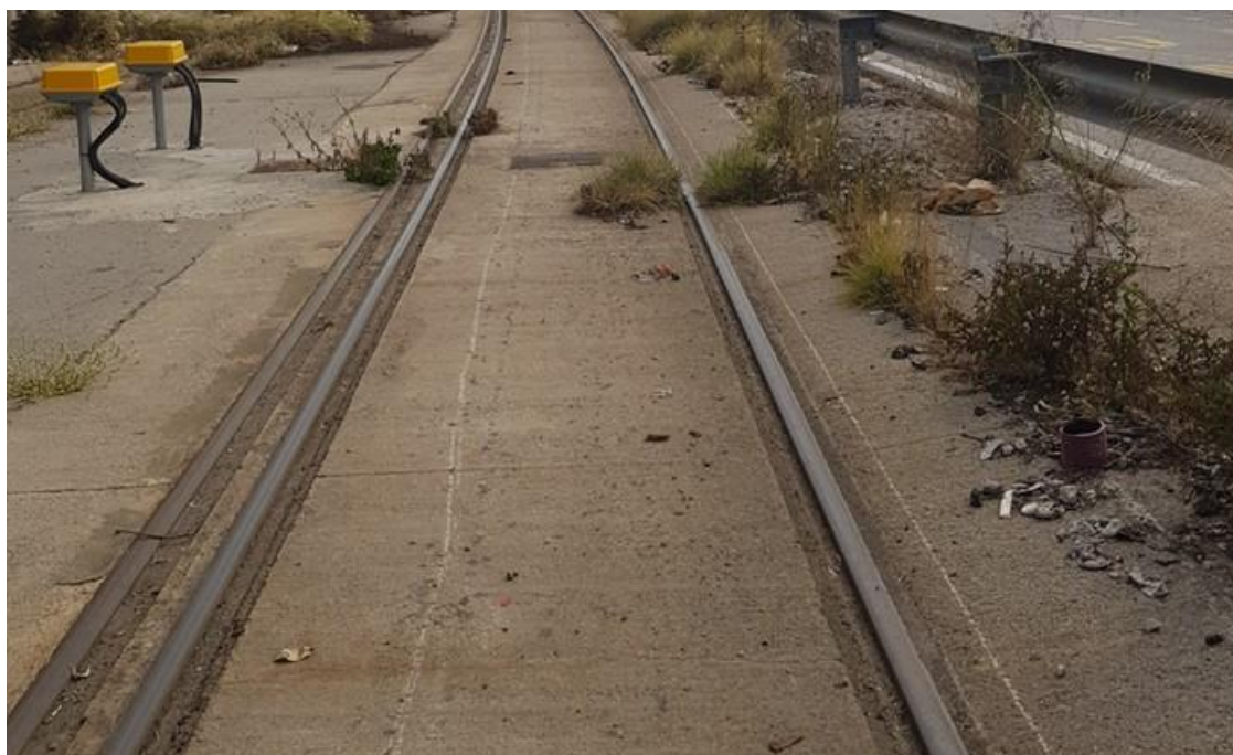
Ilustración 13: Acumulación de barro en la acanaladura de la cara activa del carril. Fuente propia.
