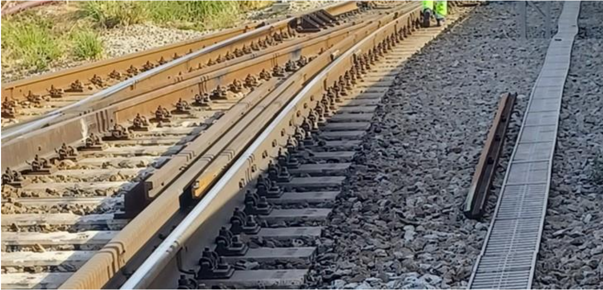
Ilustración 11: Contracarril acopiado junto a la vía, y próximo a la canaleta de cableado de instalaciones. Fuente propia.
