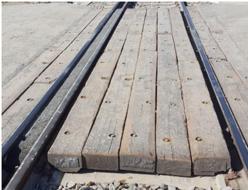
Ilustración 22: Intersección en ancho ibérico y ancho UIC mediante entablonado de traviesas de madera en el Puerto de Barcelona. Fuente propia.
