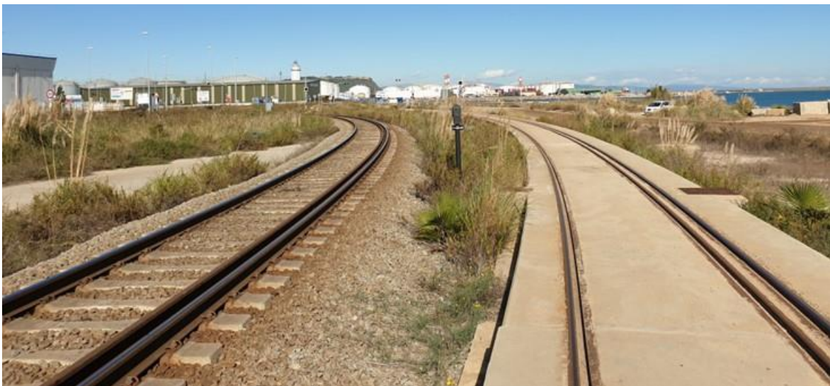
Ilustración 34: Izquierda vía mixta en balasto. Derecha vía mixta en placa con carril embebido. Puerto de Barcelona. Fuente propia.
