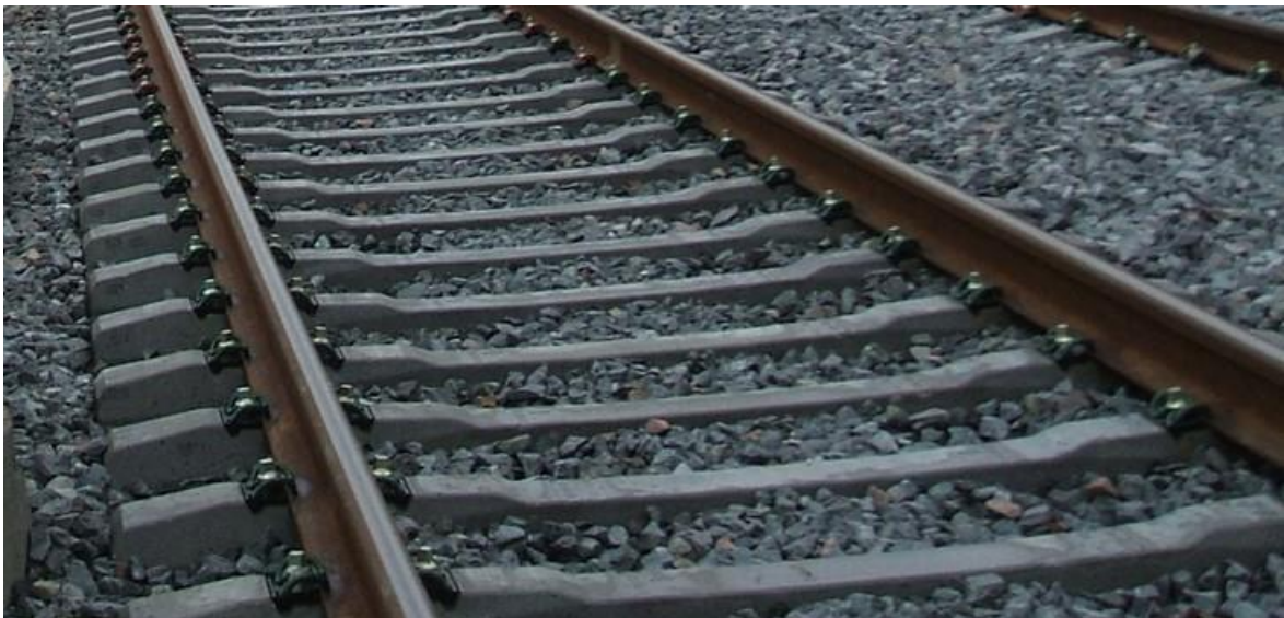
Ilustración 32: Traviesas monobloc MR-93 con sujeción elástica SKL-1 en la red convencional de Adif en el Prat de Llobregat. Año 2007. Fuente propia.
