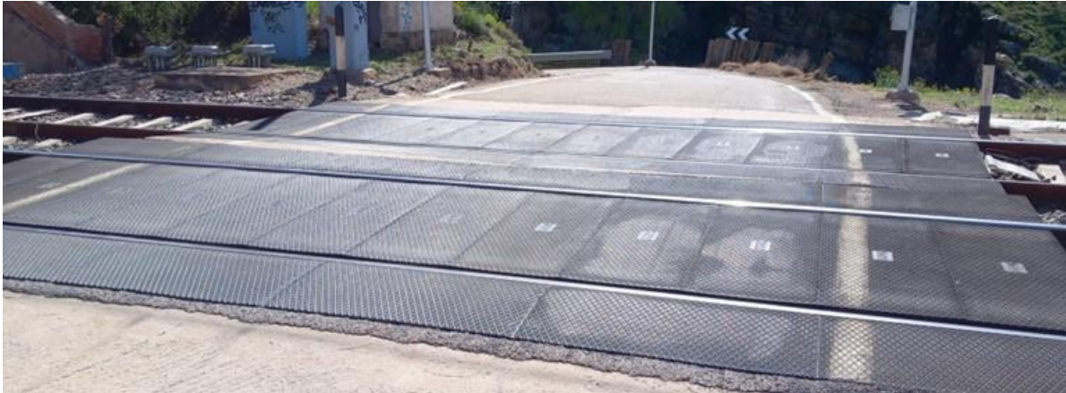
Ilustración 23: PN de paneles de caucho en la L/ Madrid-Zaragoza-Barcelona, red convencional de Adif en la estación de Embid de la Ribera. (Fuente propia).
