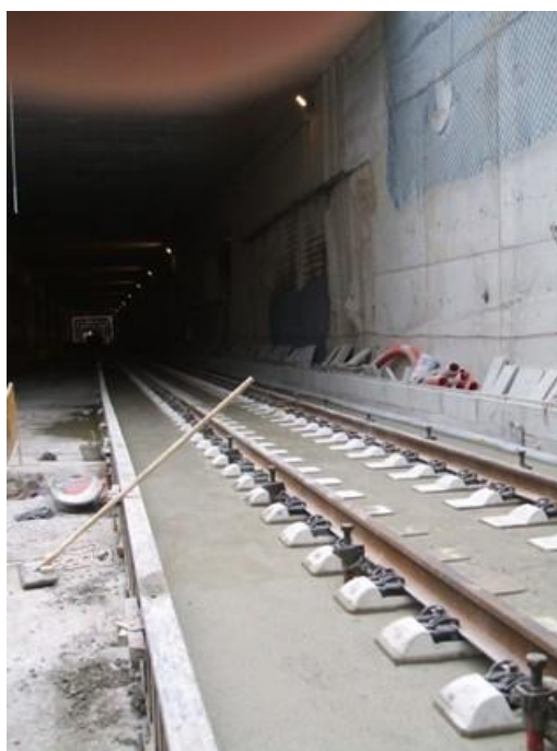
Ilustración 42: Vía en placa con traviesa Rheda 2000 [33] después de hormigonar. L.A.V. Madrid-Zaragoza-Barcelona. El Prat de Ll. Año 2007. Fuente propia.
