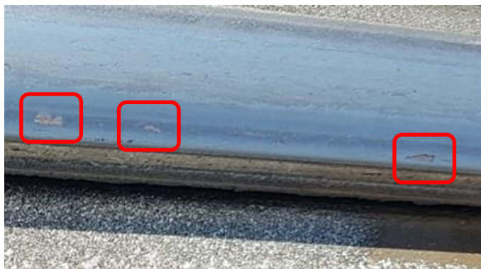
Ilustración 48: Fatiga superficial con desprendimiento de material. Fuente propia.
