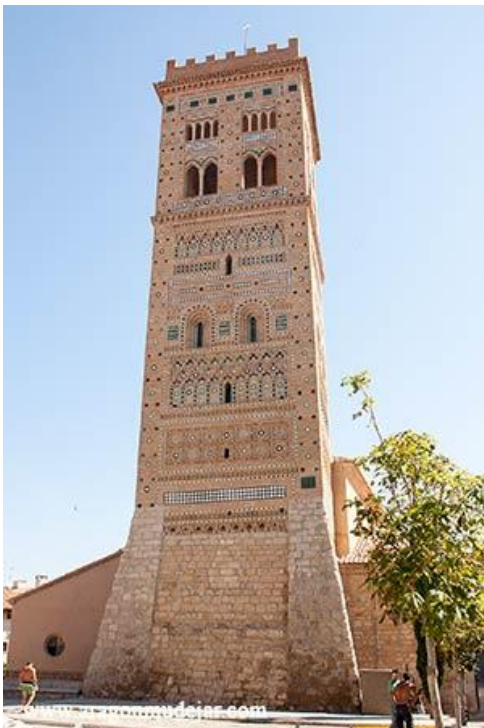
(Figura 3. Torre San Martín.)
