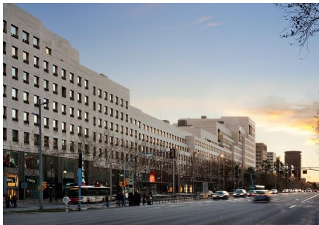
Fig 7. Moneo, R. (1987-1994). Edificio L'illa Diagonal, Barcelona . Rafael Moneo Arquitecto. https://rafaelmoneo.com/proyectos/lilla-diagonal/ .
