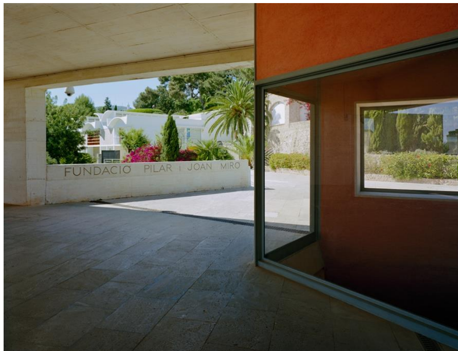
Fig 6. Moneo, R. (1987-1992). Fundación Pilar y Joan Miró, Palma de Mallorca . Rafael Moneo Arquitecto. https://rafaelmoneo.com/proyectos/fundacion-pilar-i-joan-miro/ .
