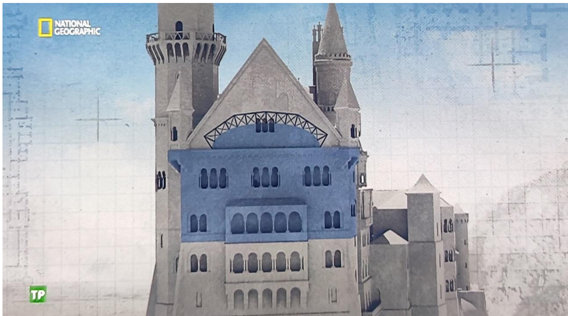
Fig. 54. Estructura de metal sobre la cúpula de la sala bizantina para darle estabilidad.
