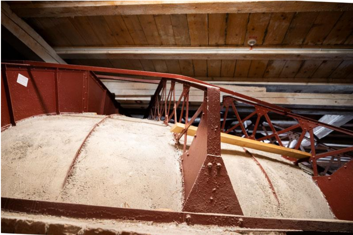
Fig. 53. Estructura de metal sobre la cúpula de la sala bizantina para darle estabilidad.
