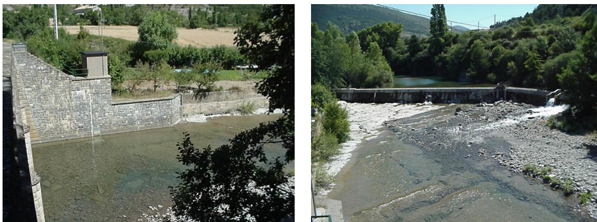
Foto 4. Estación de aforo A018 Río Aragón en Jaca. Fuente: SAIH Ebro.
