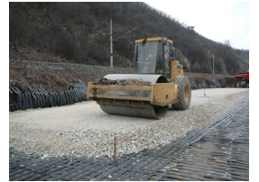
Figura 57. Construcción de terraplén.
