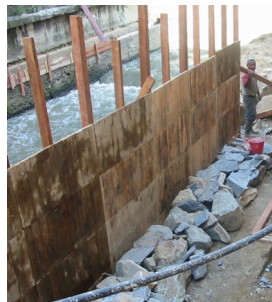
Figura 25. Reconstrucción con muros ciclópeos del canal La Quebrada Caroata. (Caracas), 2004. Fuente: EcoGreen Construcciones.
