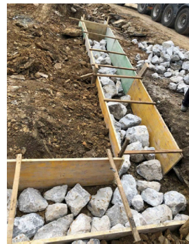
Figura 28. Colocación de los bolos en la base del encofrado. Fuente: Blog IEB.
