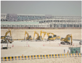
Figura 34. Fase de excavación en la construcción del estadio. Fuente: BDP Pattern.
