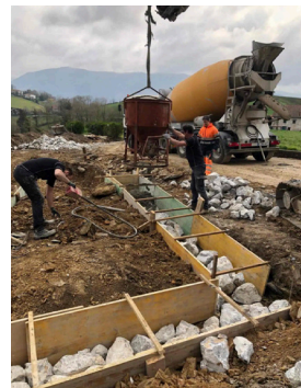
Figura 29. Vertido del hormigón. Fuente: Blog IEB.
