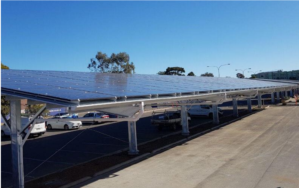
Fig. 9. Estructura “carport” en una zona de estacionamiento. Fuente: (ANTAI)
