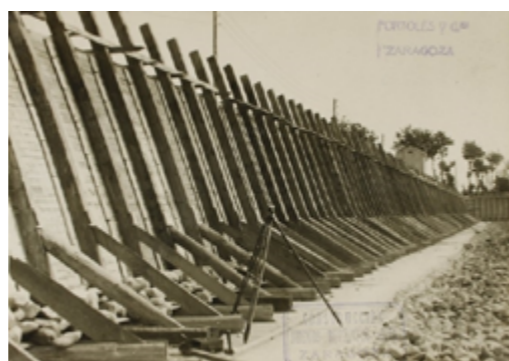
figura 11: Marín Chivite, construcción de los nuevos depósitos de agua Zaragoza (1928)
