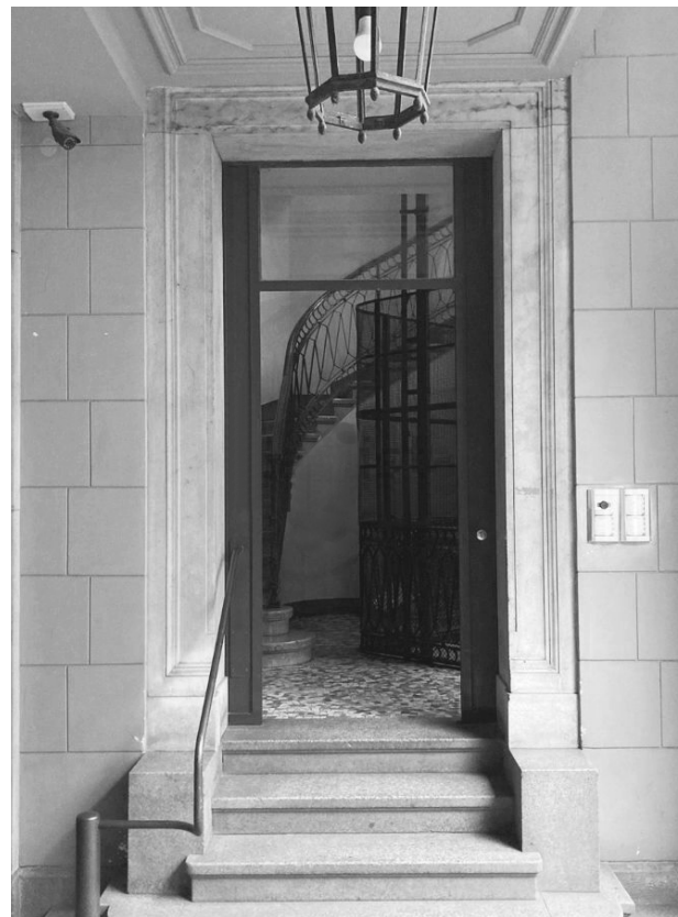
Figura 30: Bloque entre medianeras en esquina Piazza Sant Ambrogio, 16, Milán. Luigi Caccia Dominioni, 1947-1950. Acceso a la escalera helicoidal y ascensor.
