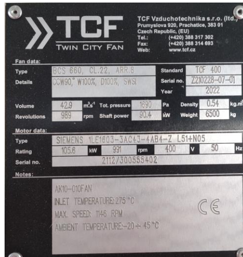
Figura 18: Placa ventilador Z1-VRI (Elaboración Propia, 2023)
