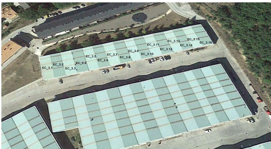
Ilustración 14. División de la cubierta en 16 áreas diferenciadas. [Fuente: Google Earth Pro]
