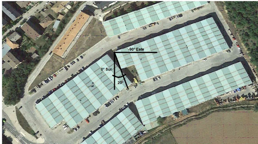
Ilustración 10. Cálculo del Azimut de las cubiertas EC_3, EC_4 y EC_5. [Fuente: Google Earth Pro]
