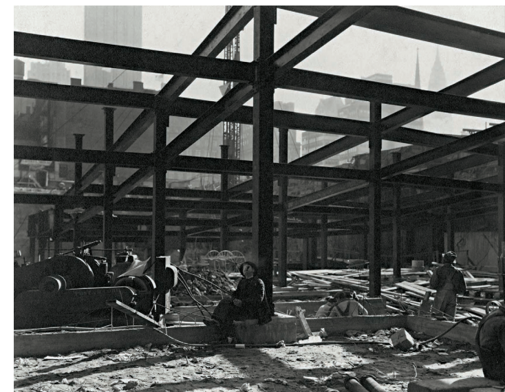
Construcción del Rockefeller Center, 1932: Después de hincar en el suelo los grandes y profundos pilotes que iban a soportar el edificio, se empezaba a configurar el tramado metálico que iba a dar forma al mismo.
