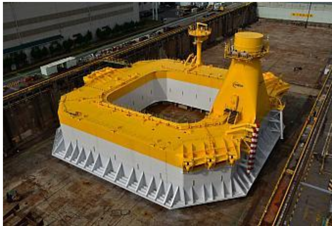
Figura 25. Construcción de plataforma flotante tipo Barge en dique seco. (Fuente: BW Ideol [32])
