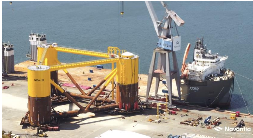
Figura 22. Ensamblaje de plataforma en muelle. (Fuente: STGO [28])
