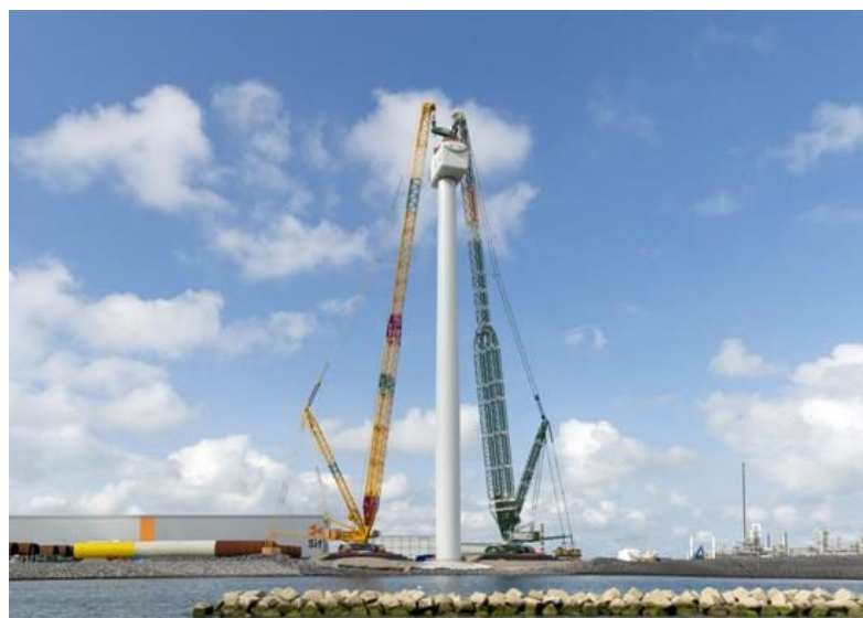
Figura 35. Grúas sobre orugas LIEBHERR LR 11350. (Fuente: MOVICARGA [41])
