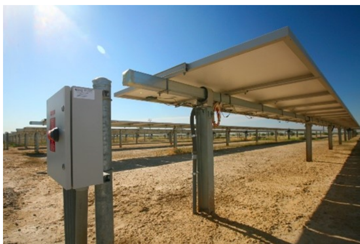
Ilustración 3.1: Instalación de una caja de combinación en una instalación solar [10]
