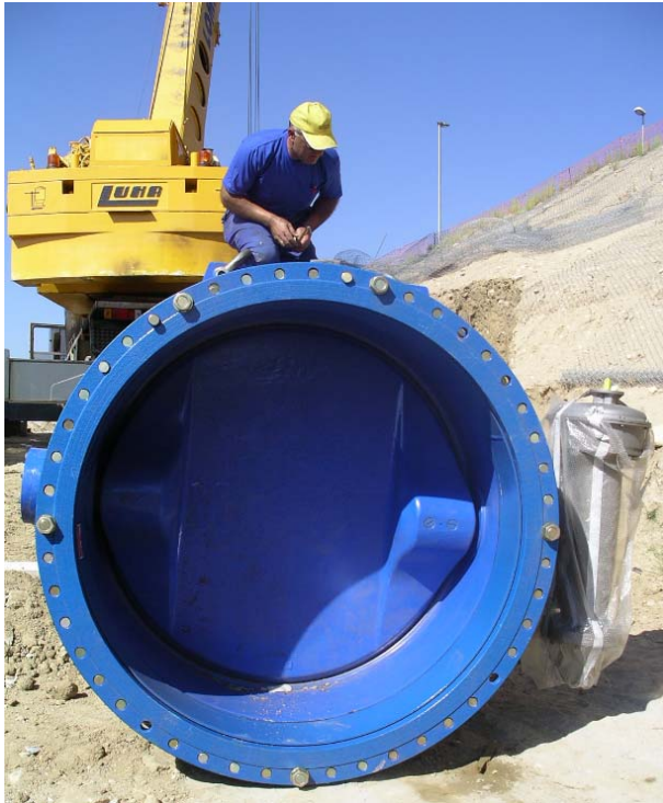
Instalación horizontal y vertical
