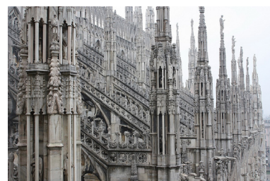
[5] Los arbotantes se convirtieron en un elemento indispensable en el gótico. Al colocarlos sobre los arbotantes cumplían la doble función de añadir contrapeso y estética. Catedral de Milán (comenzada en 1386).
