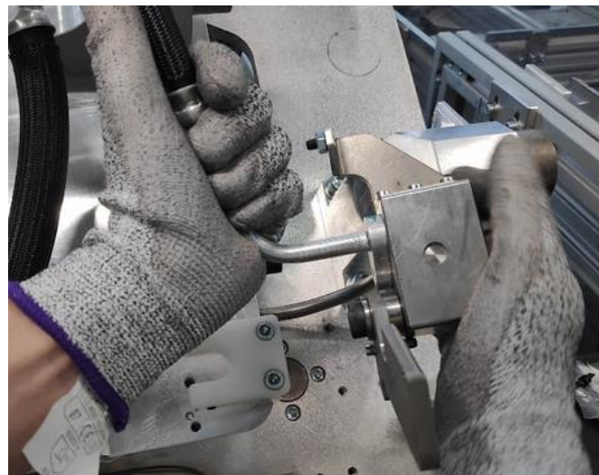
Imagen 3.1.6 Conexión de los tubos a las torres de la paleta
