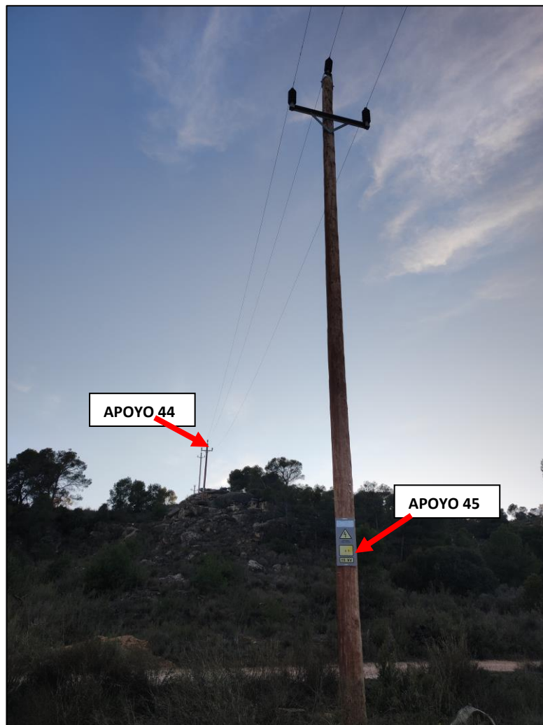
Fig. 38: Apoyo 44 y Apoyo 45
