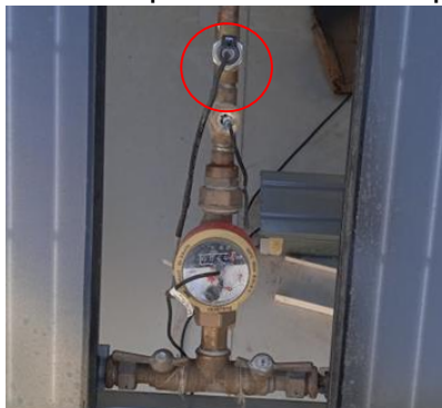
Figura 33: Imagen del sensor de presión.
