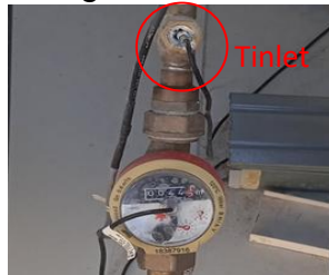
FIGURA 36: Imagen de la sonda Tinlet.
