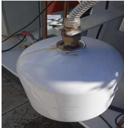
Figura 31: Imagen del vaso de expansión.
