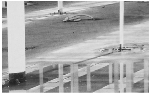
Tirantes suspendidos y detalle de esperas en la losa
