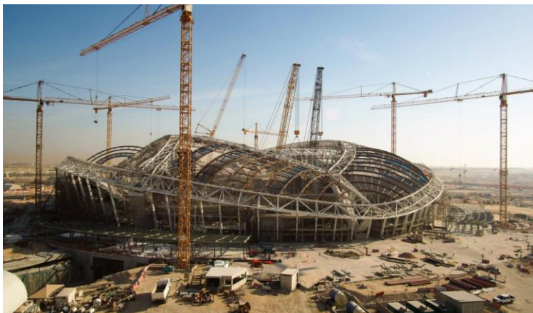
Construcción desde el exterior del estadio Al Janoub.
