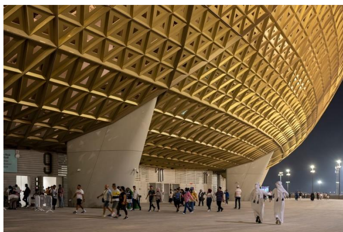
Imagen estructura exterior del estadio Lusail.
