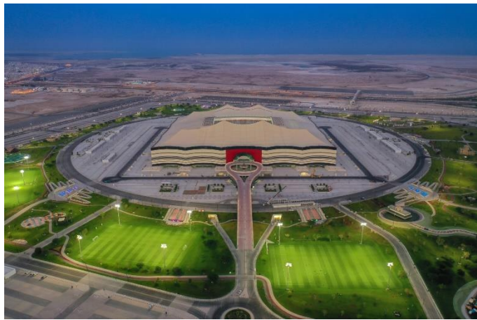
Vista exterior del estadio. Metalocus.
