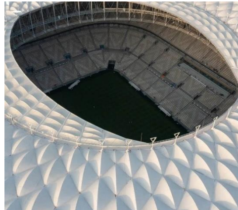
Imagen cubierta del estadio Lusail.
