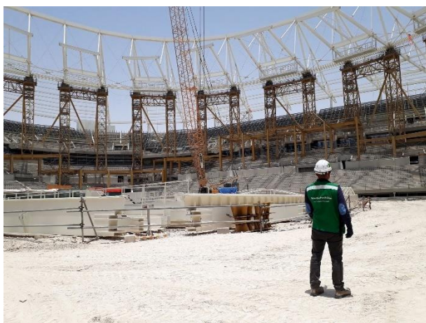
Construcción del estadio Ahmad Bin Ali.
