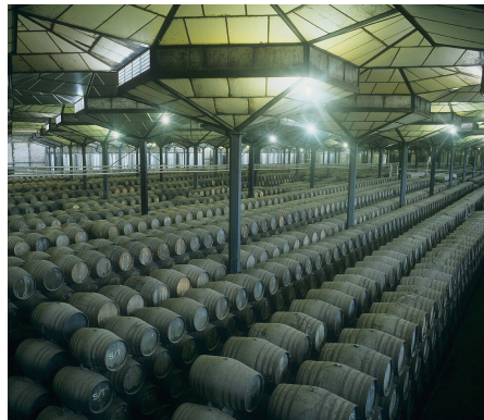
8. Bodega "Las Copas" de González Byass, Jerez de la Frontera, Cádiz. Jose Antonio Torroja. 1969-1974 Fuente: https://www.stockfood.com.mx/images/00291903-Gonzalez-Byass-bodega-Las-Copas-Jerez-de-la-Frontera-Spain
