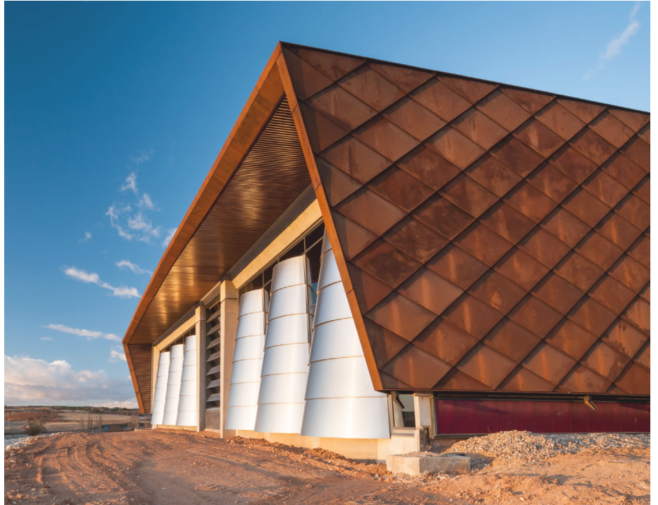
Figura 29 Exterior de la nave de fermentación, con mayor luz y ventilación que las naves de barricas y botellas. Fuente: https://divisare.com/projects/146697-filippo-poli-foster-partners-nigel-young-faustino-winery
