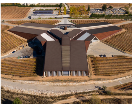
16. Bodegas Portia, Gumiel de Izán, Burgos. Foster and Partners. 2006-2010. Fuente: https://www.facebook.com/BodegasPortia/photos/
