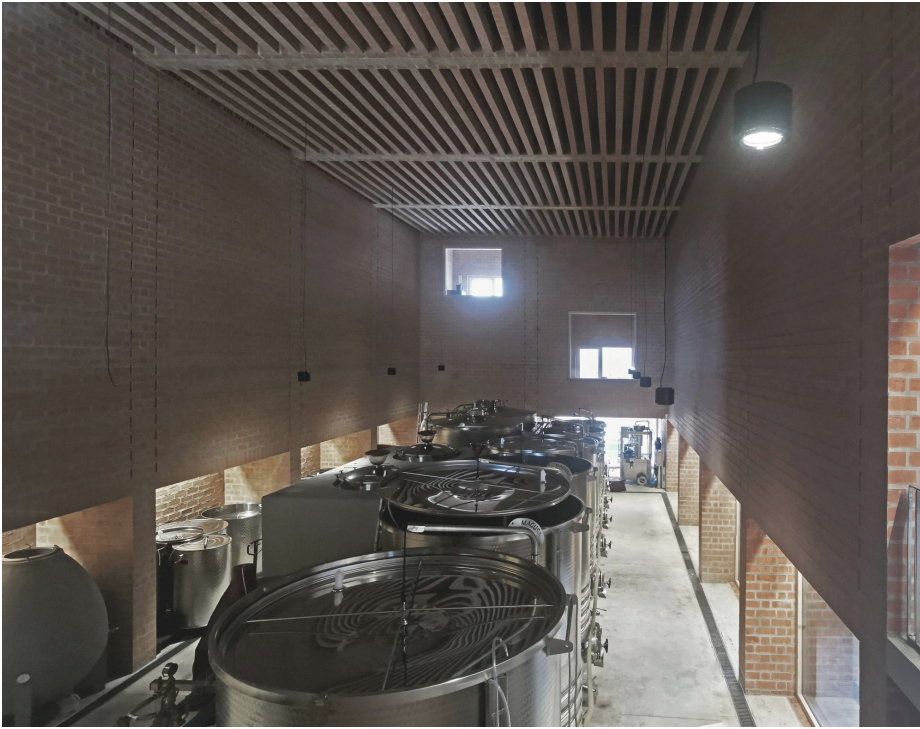
Figura 21 Sala para depósitos de fermentación, en primer plano, y al fondo acceso de mangueras desde la zona de recepción de la uva y maquina de embotellado Fuente: https://diario16.com/acronimos/
