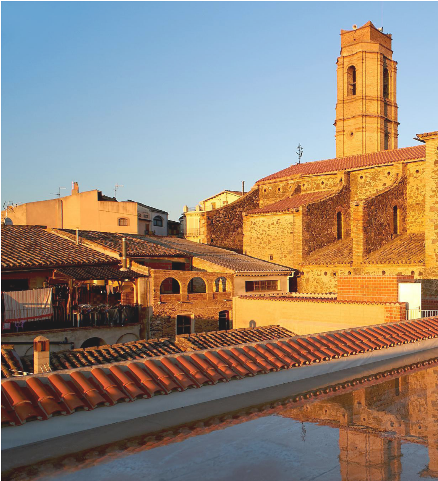
Figura 50 Cubierta de la bodega Clos Pachem en primer plano y vistas a la iglesia parroquial de San Lorenzo en Gratallops. Se observa la lámina impermeable de PVC color blanco para que durante el día cuando el agua descienda, se refleje la radiación solar. La imagen muestra el momento en que el agua asciende a la cubierta antes del anochecer. Fuente: https://www.turismepriorat.org/ca/que-fer/ruta-dels-cellers/clos-pachem
