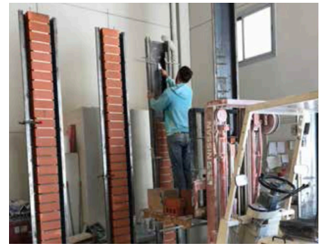
Figura 47. Proceso de prefabricación de dinteles y viguetas en taller. Fuente: "Memoria constructiva", https://www.clospachem.com/arquitectura/
