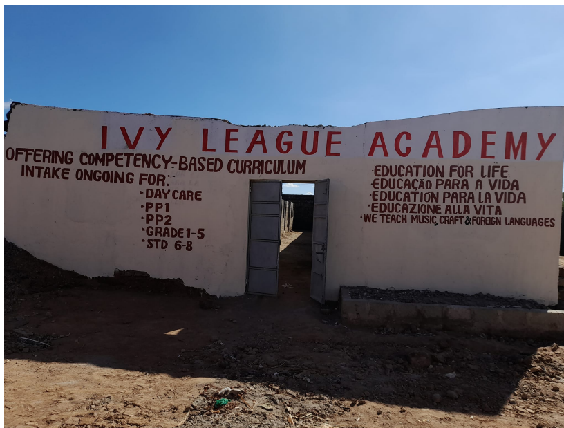
Figura 3.1: Imagen de la fachada de la actual escuela.
