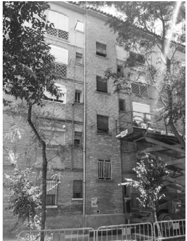
Figura 2.6: Fachada posterior. Núcleo de escaleras.
