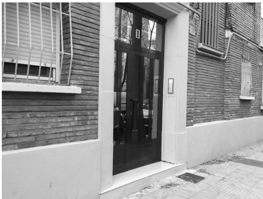
Figura 2.16: Fachada principal. Puerta de acceso.
