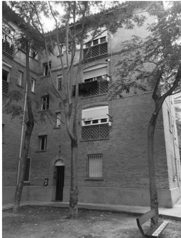
Figura 2.27: Fachada principal. Puerta de acceso.
