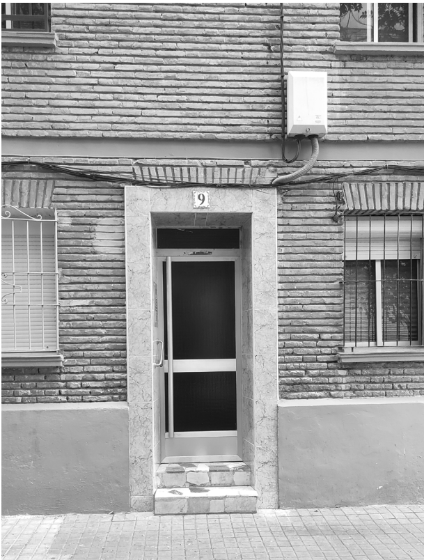
Figura 2.5: Fachada principal. Puerta de acceso.
