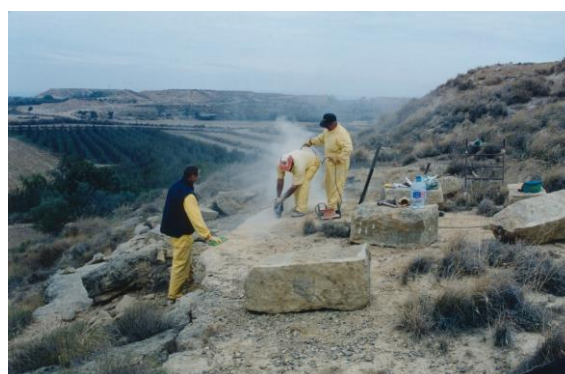
Figura 4. Trabajos de extracción de piedra arenisca en la cantera situada en la margen suroccidental del cerro destinada a la consolidación de la arquitectura realizada en el año 2000. (Img. Empresa Al-mulk, S.A.).
